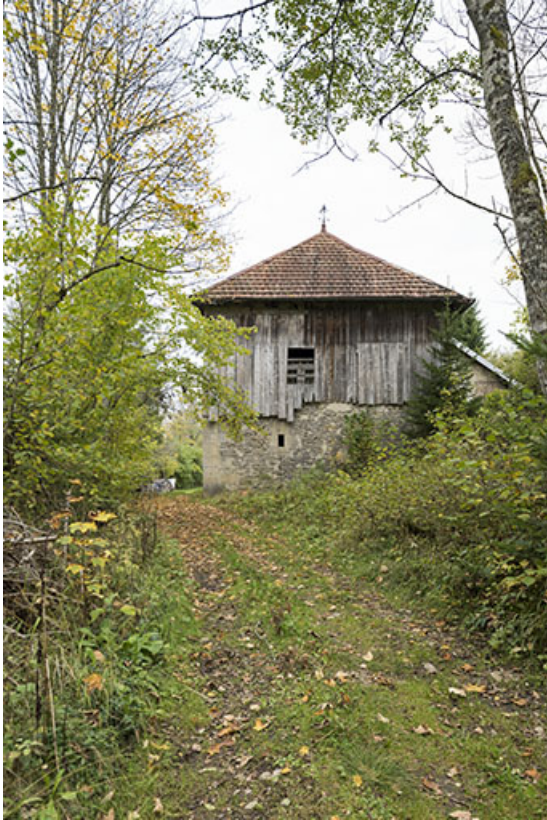
Scierie : façade sud.
