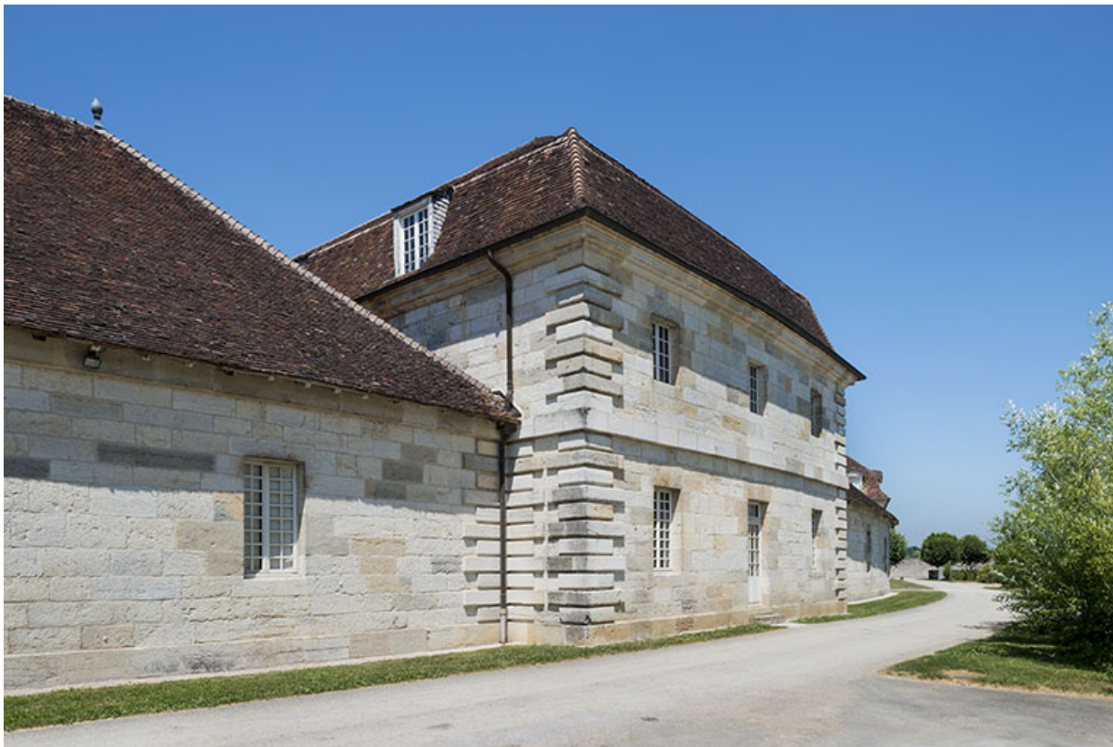
Façade postérieure du logements des ouvriers ouest.
