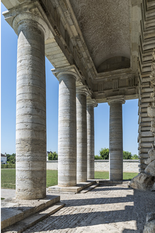
Détail du portique d'entrée.
