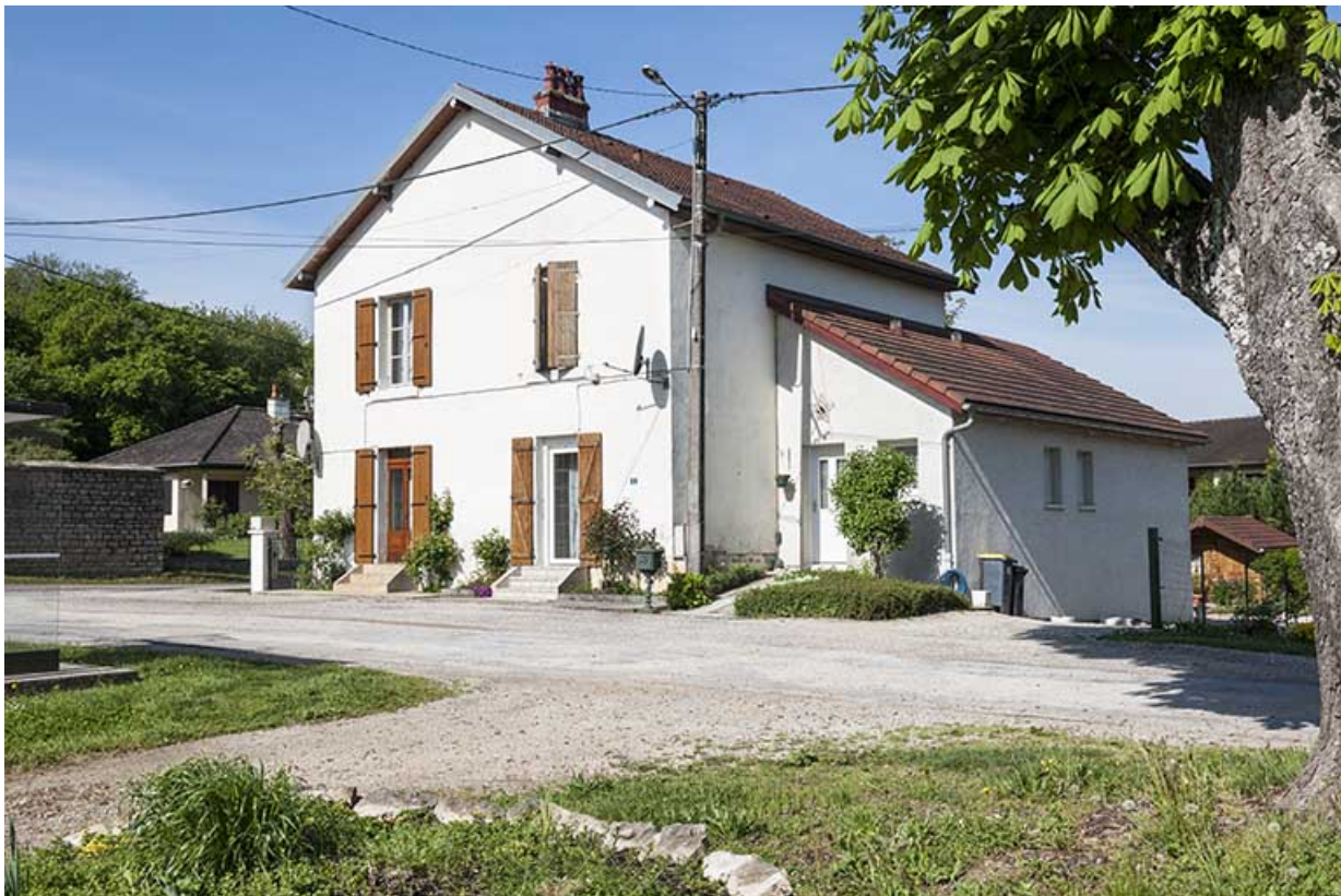
Logement ouvrier double (8-10 allée des Rompeux).
