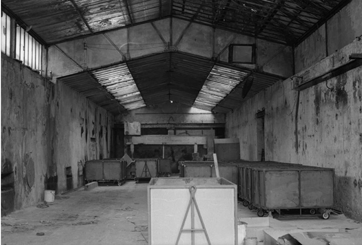
Bâtiment I : machines à papier.
