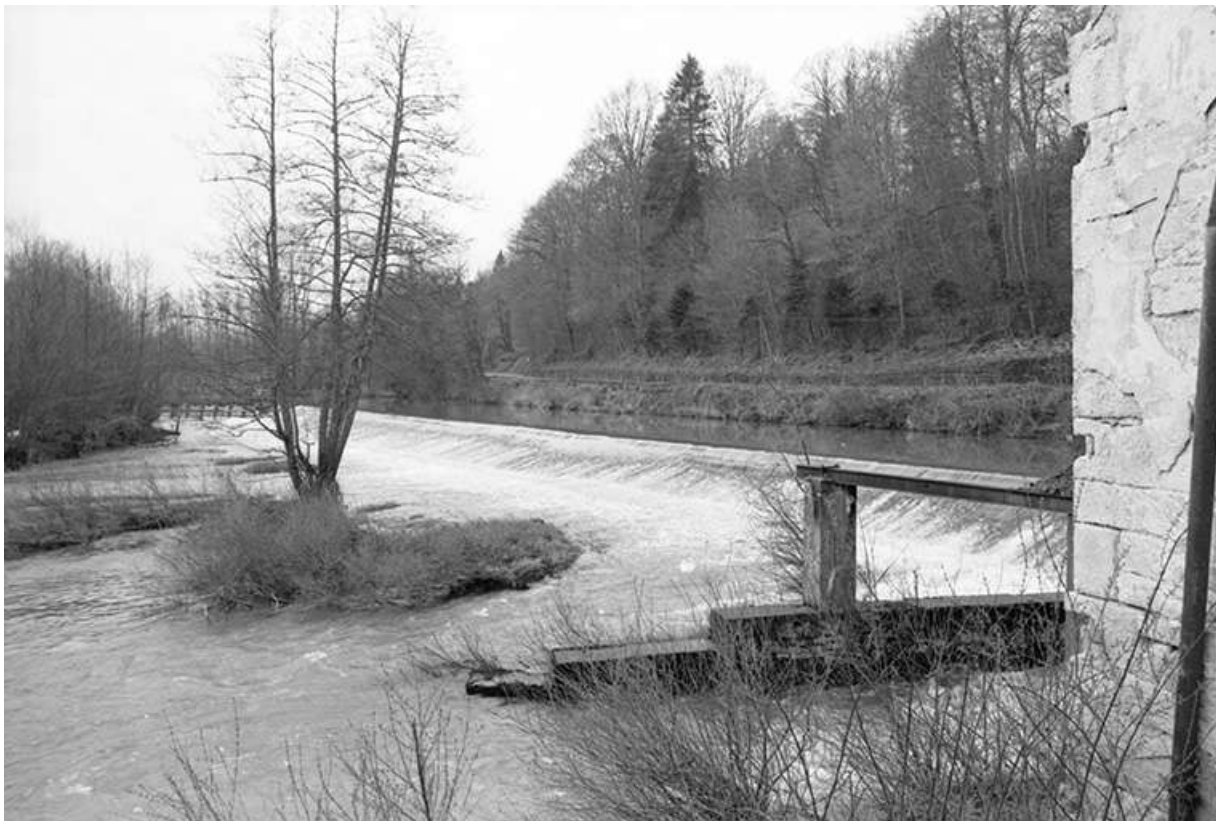
Vue du barrage.
