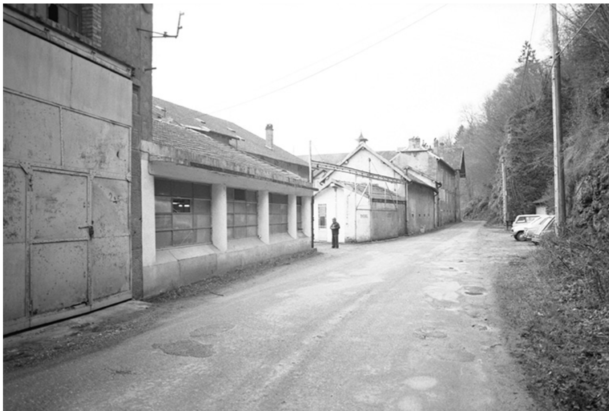
Entrée. Bureaux (L) au 1er étage.
