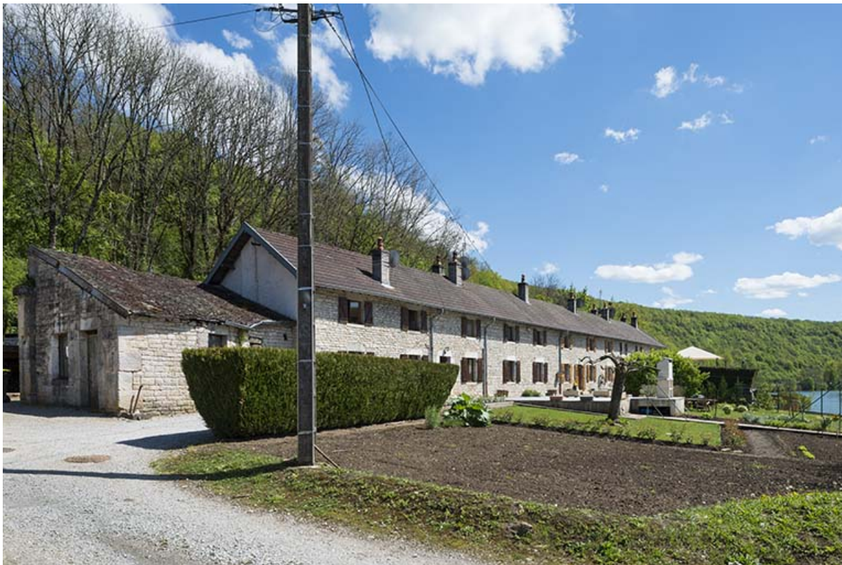
Logement ouvrier sud. Vue de trois quarts.
