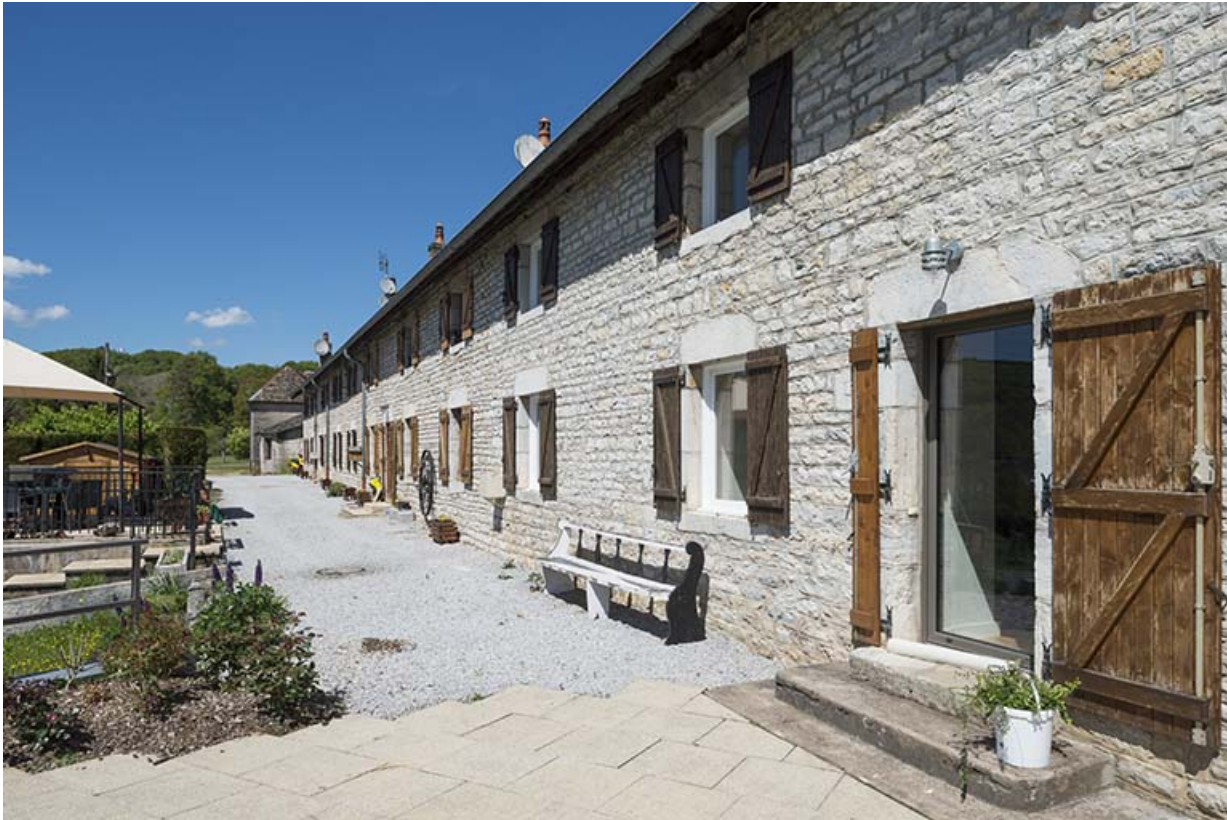
Logement ouvrier. Façade antérieure de l'aile sud.
