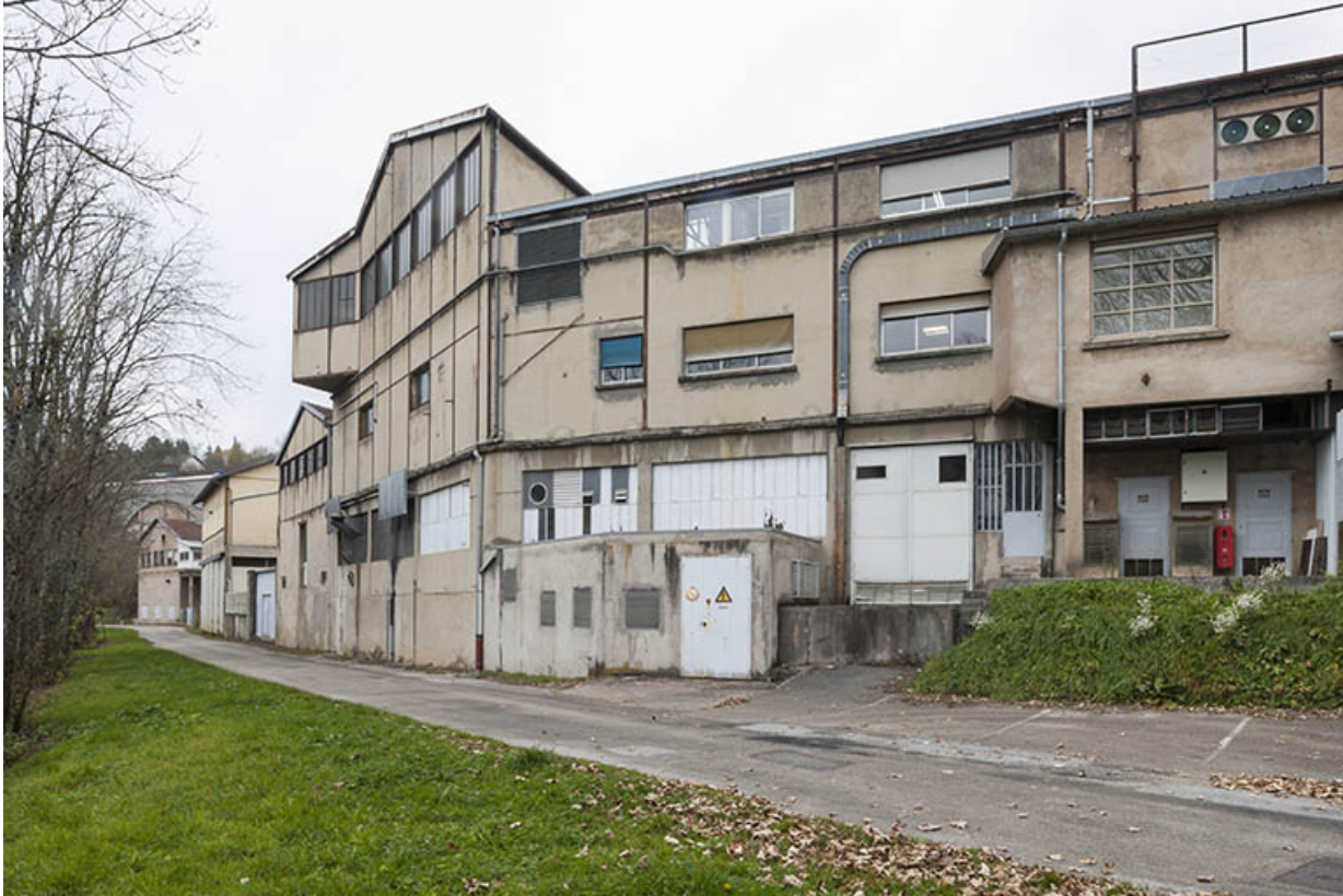
Façades sud de l'atelier de fabrication.
