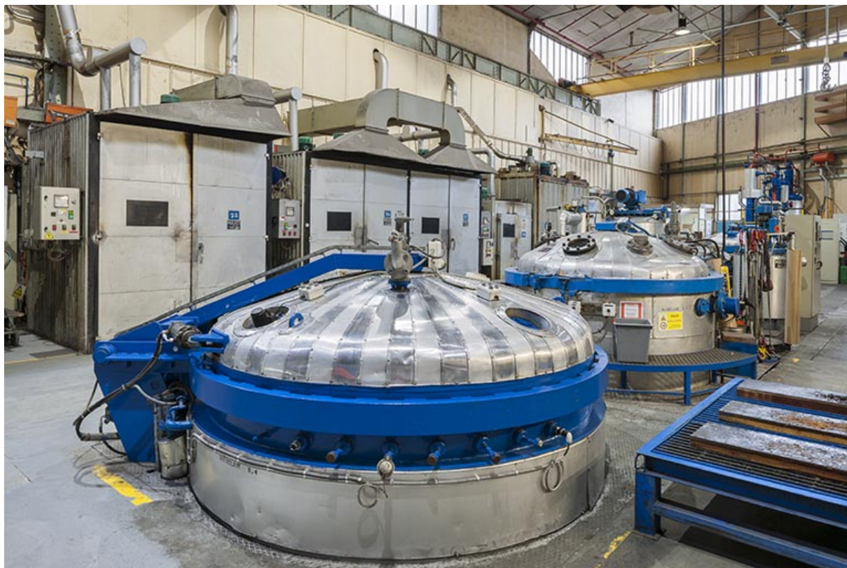
Autoclaves (imprégnation de vernis des stators).
