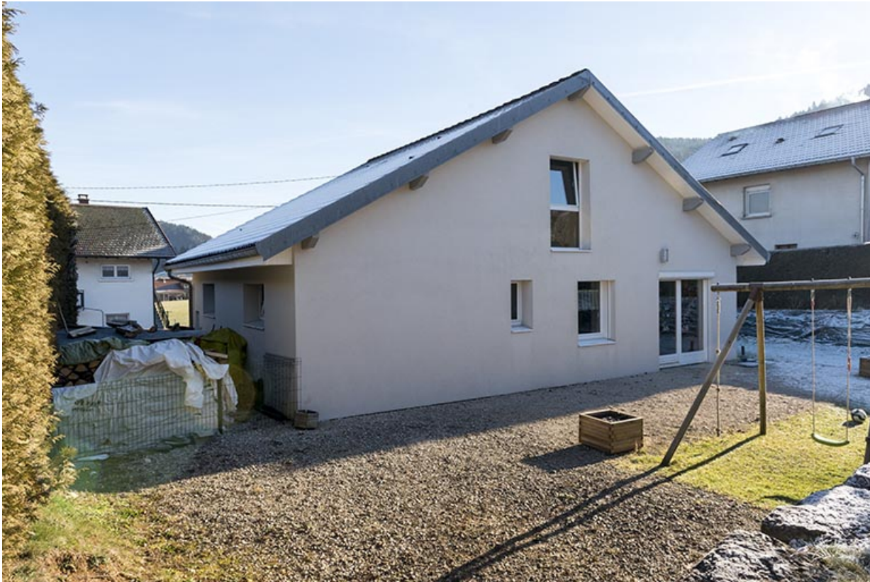
Façades postérieure et latérale droite.
