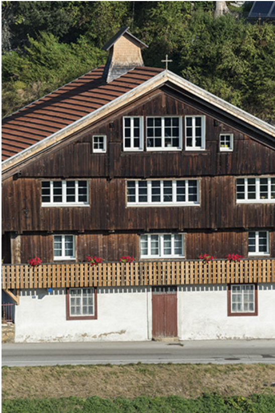
Façade antérieure : travées centrales.
