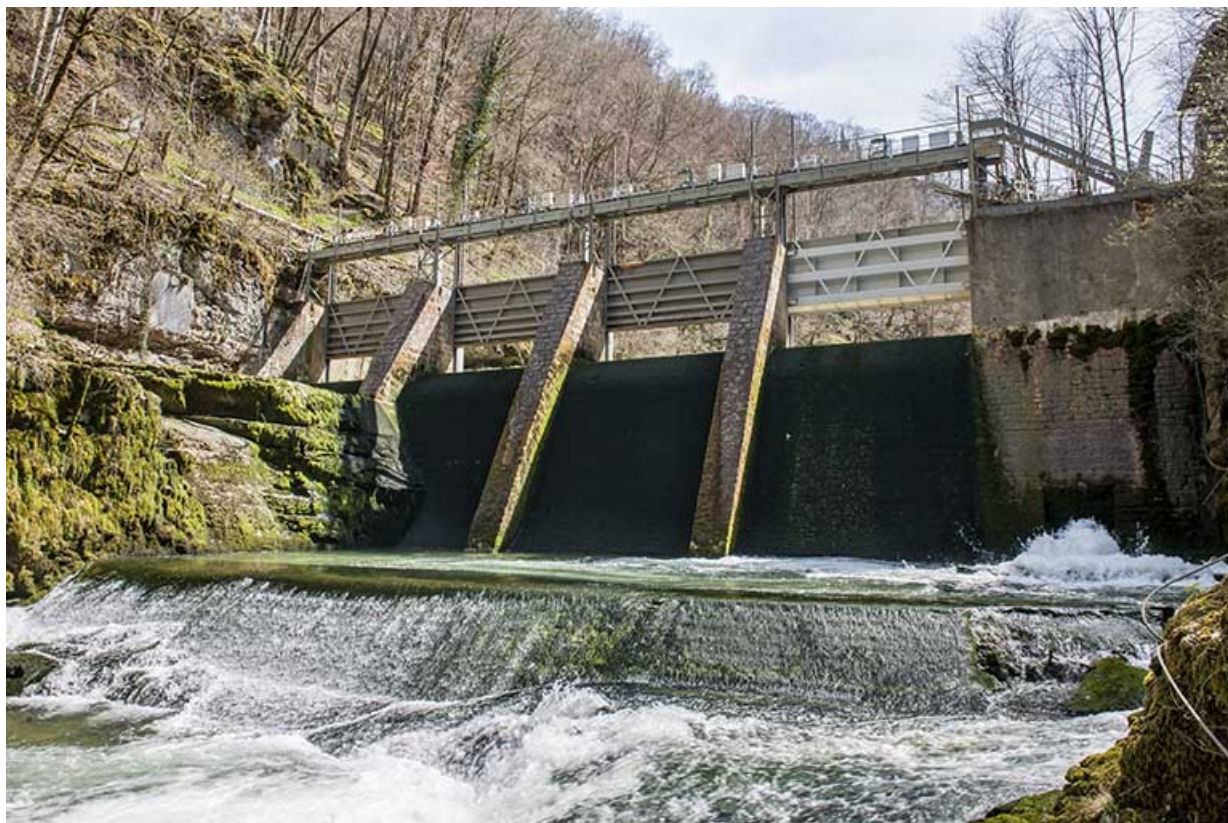
Barrage de la retenue, depuis l'aval.
