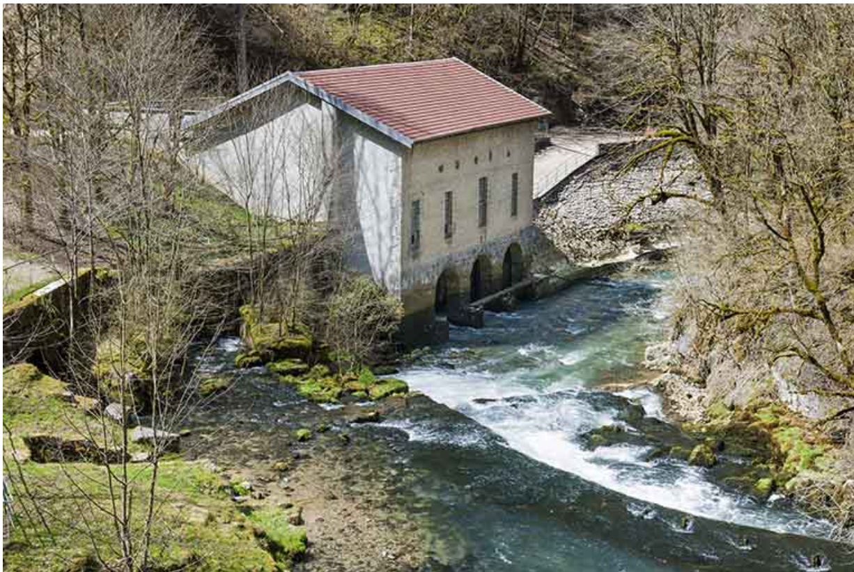
La centrale hydroélectrique depuis l'amont.
