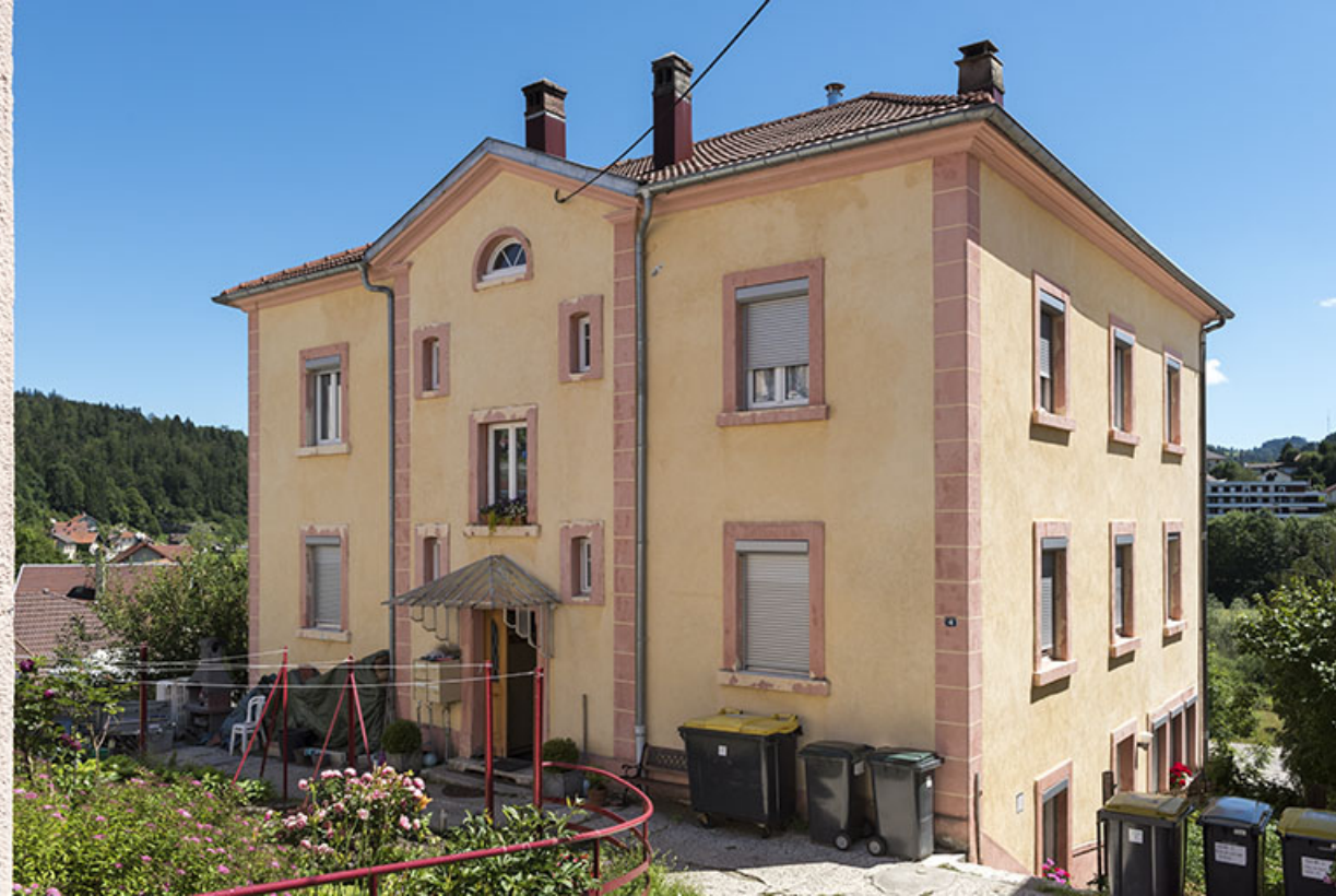
Façades antérieure et latérale droite.
