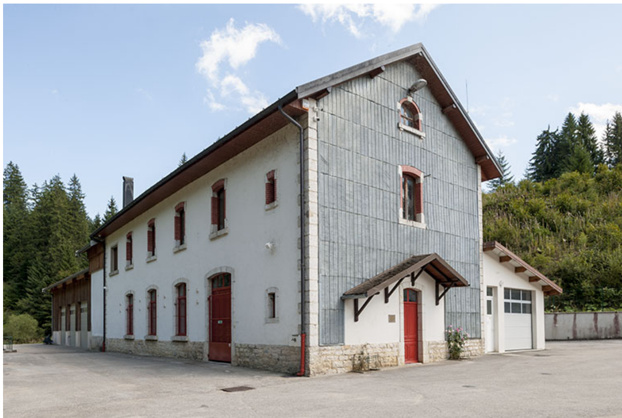
Centrale vue de trois quarts droite.
