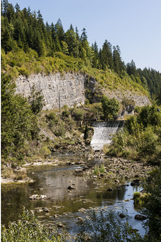
Le barrage dans les gorges de Fourpéret.
