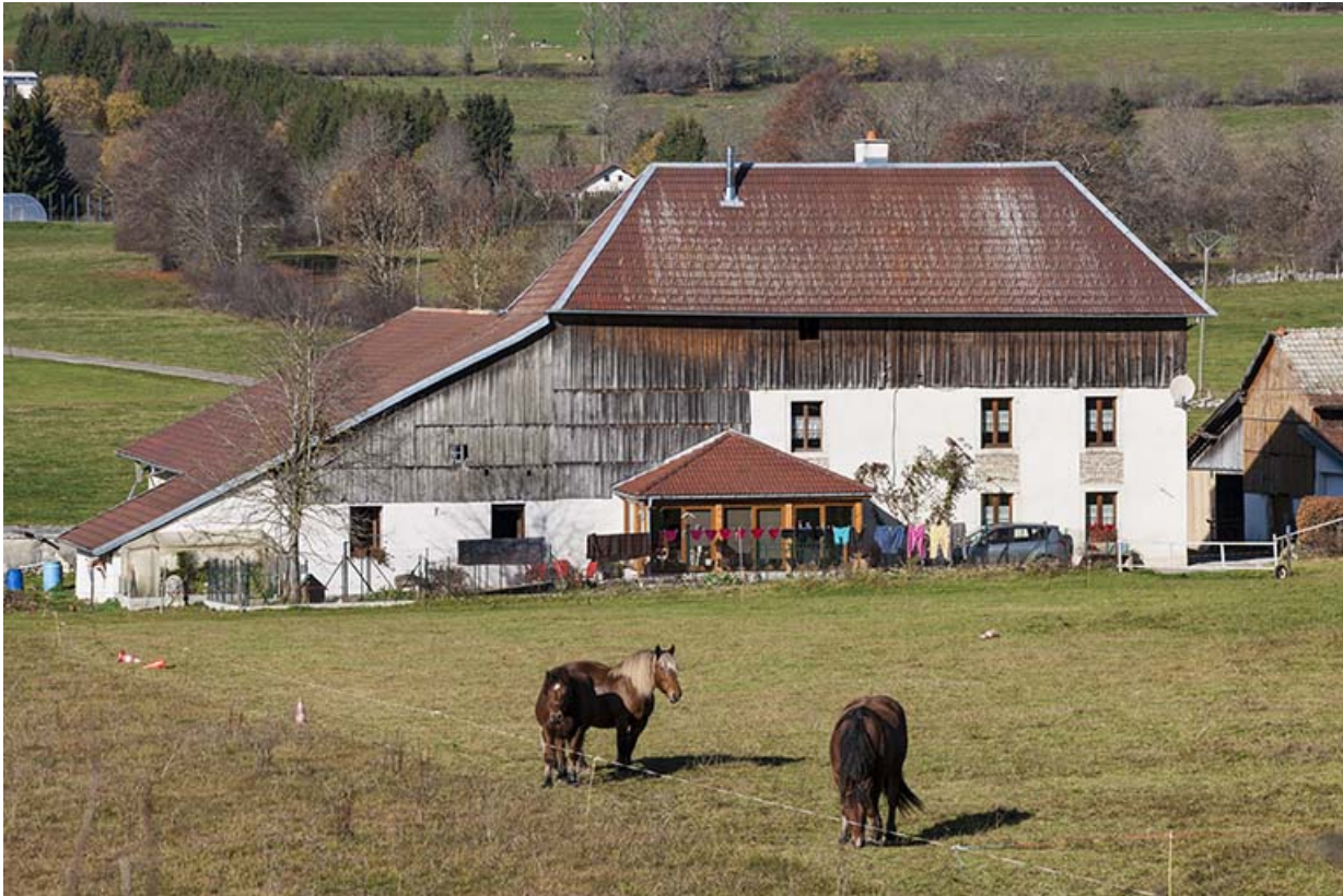
Ferme : façade sud.
