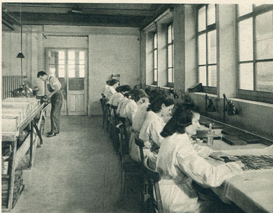
MAICHE Préparation des pierres pour le perçage
