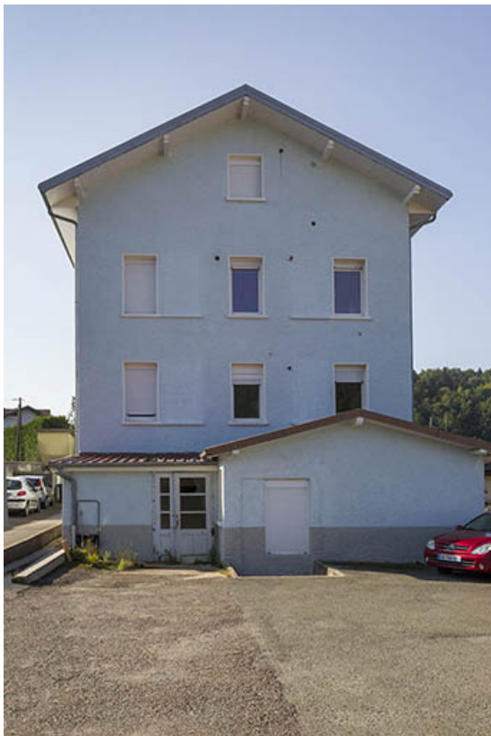
Façade latérale droite.
