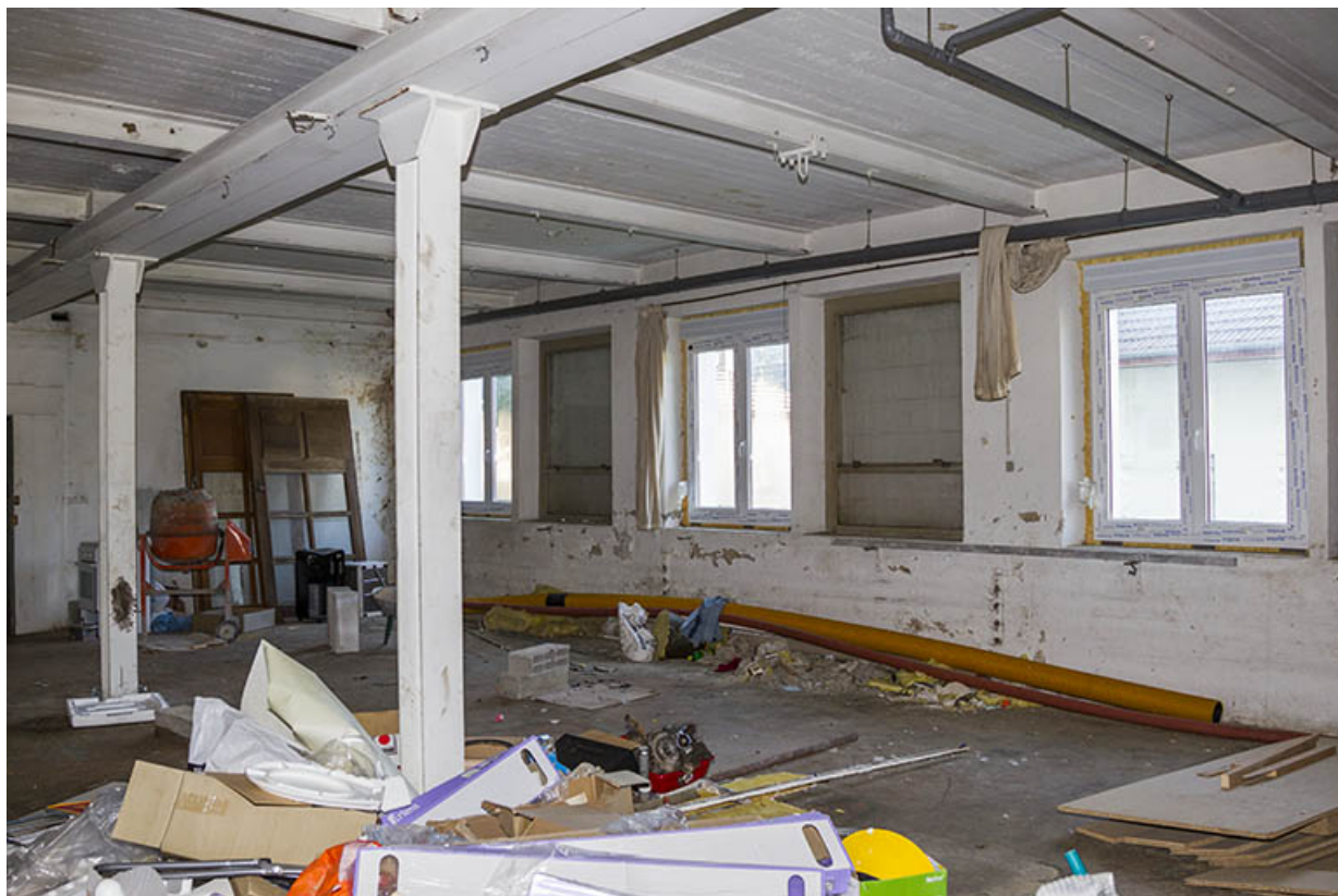
Atelier au rez-de-chaussée.
