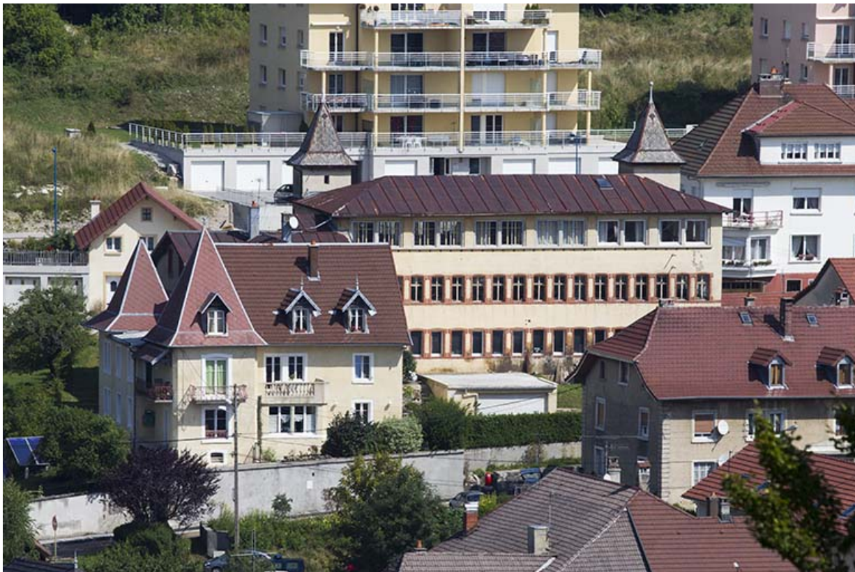
Vue d'ensemble plongeante, depuis le sud.
