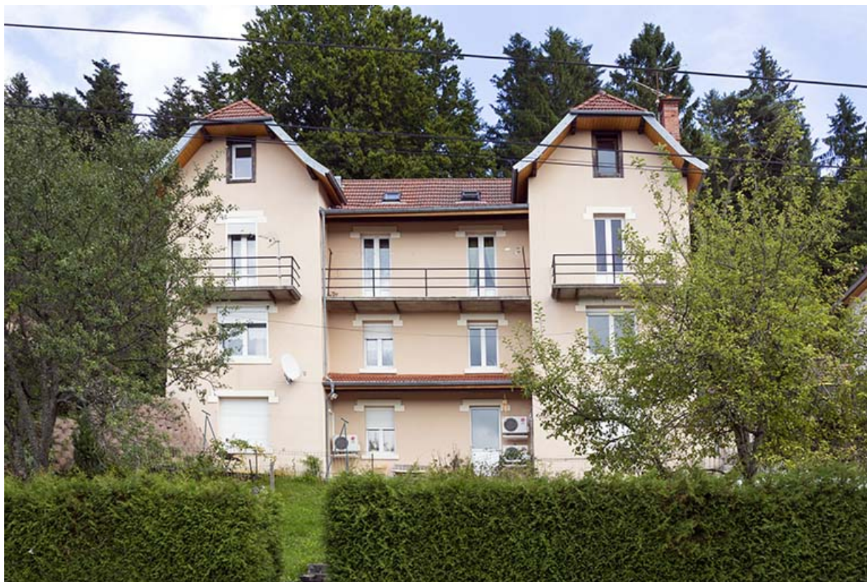
Immeuble n° 4 : façade côté vallée (ouest).
