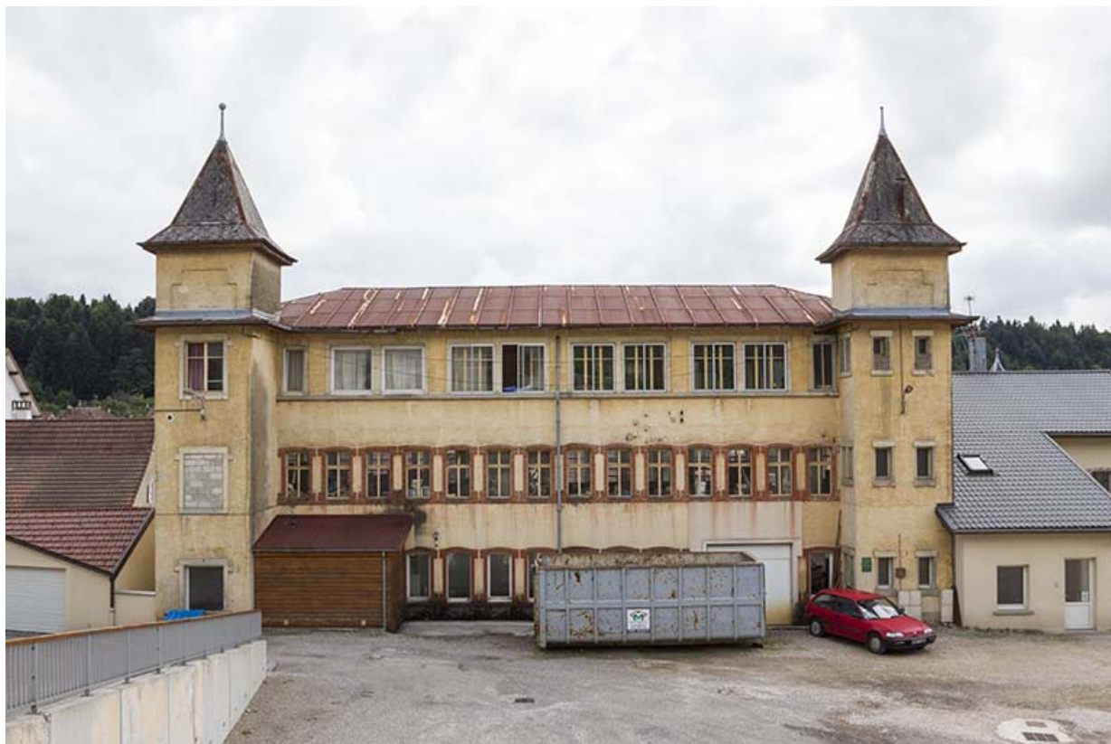
Usine : façade postérieure.
