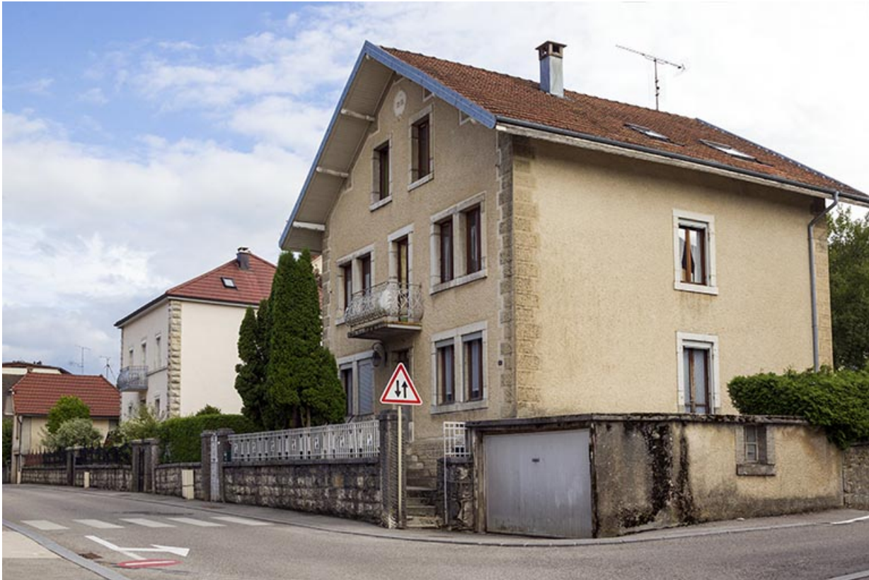
Vue d'ensemble du site, depuis l'ouest. 25, Maîche
