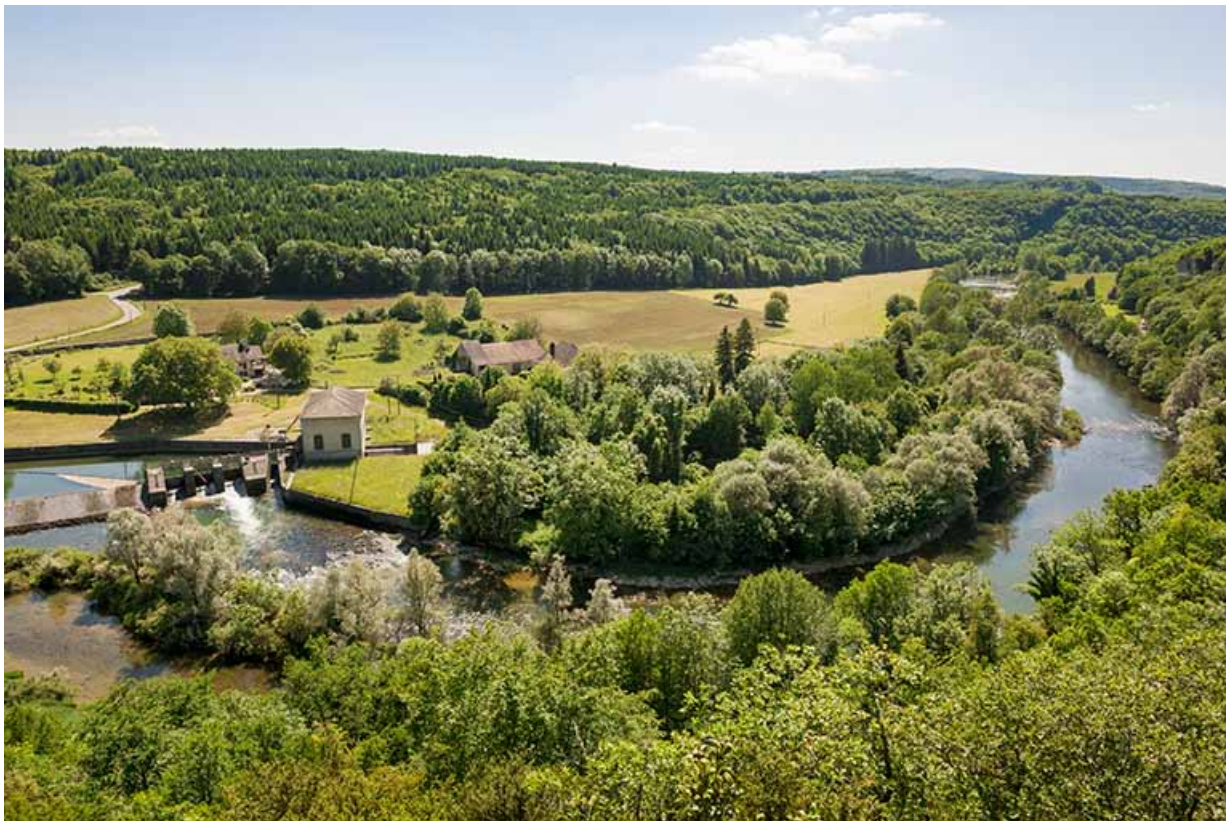
Vue plongeante d'ensemble depuis le nord-est.
