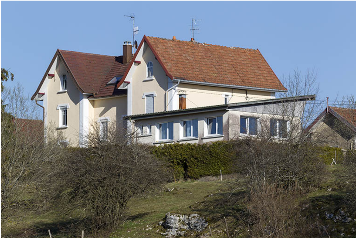
Vue d'ensemble, depuis l'ouest (maison et atelier).
