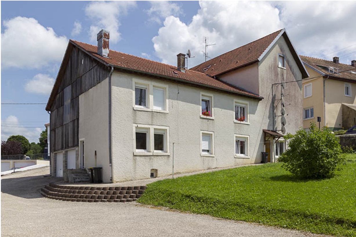
Aile en retour : façades nord et ouest.
