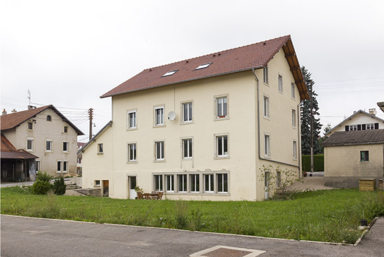
Façades postérieure et latérale droite.
