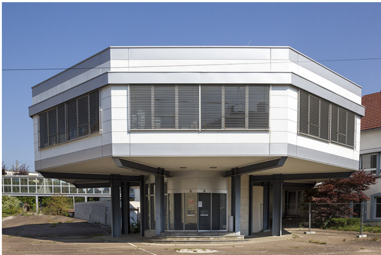
Usine : corps d'entrée.
