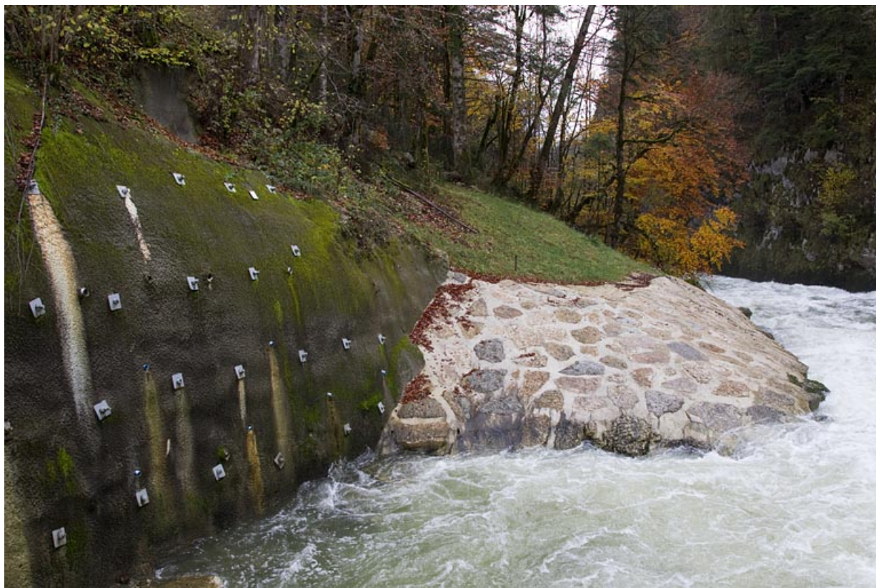
Berge renforcée en aval des vannes toit.
