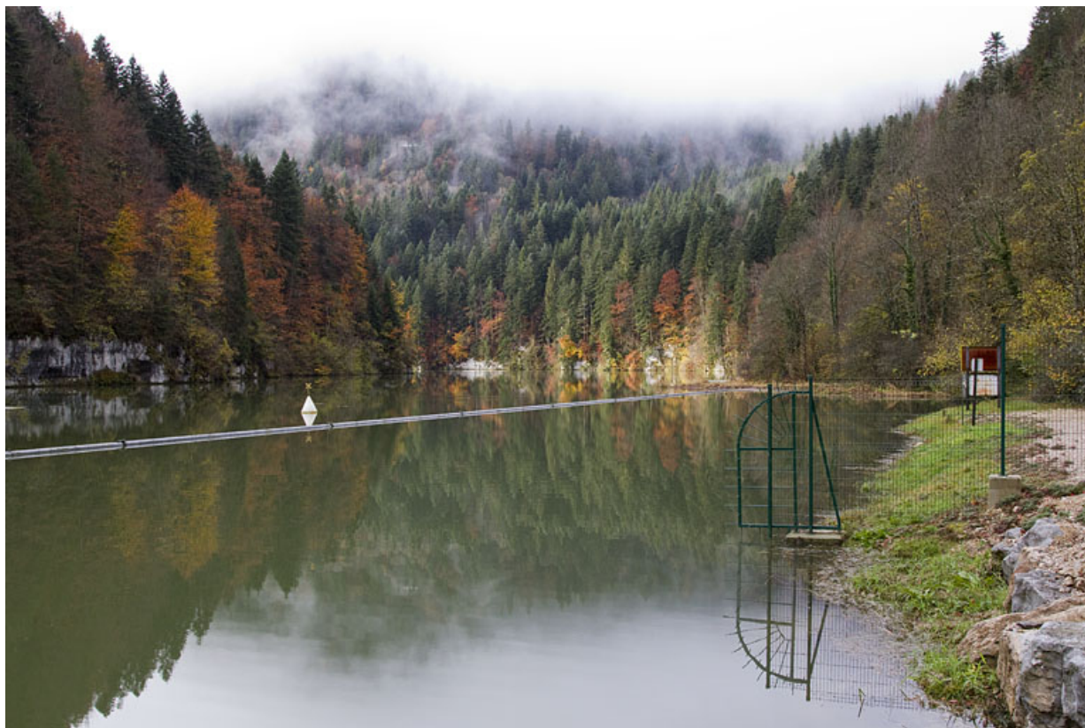
Le bassin de retenue, depuis le nord-est.
