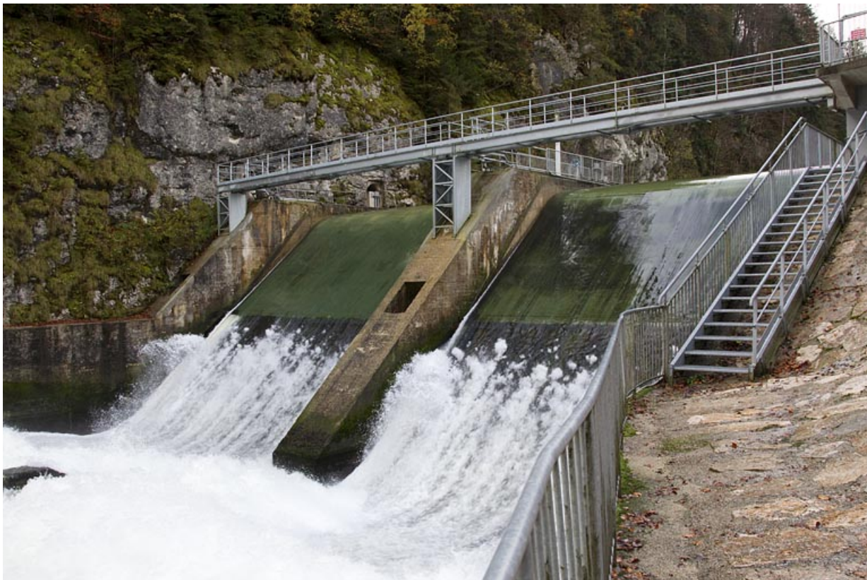
Barrage vu de trois quarts, depuis l'aval.
