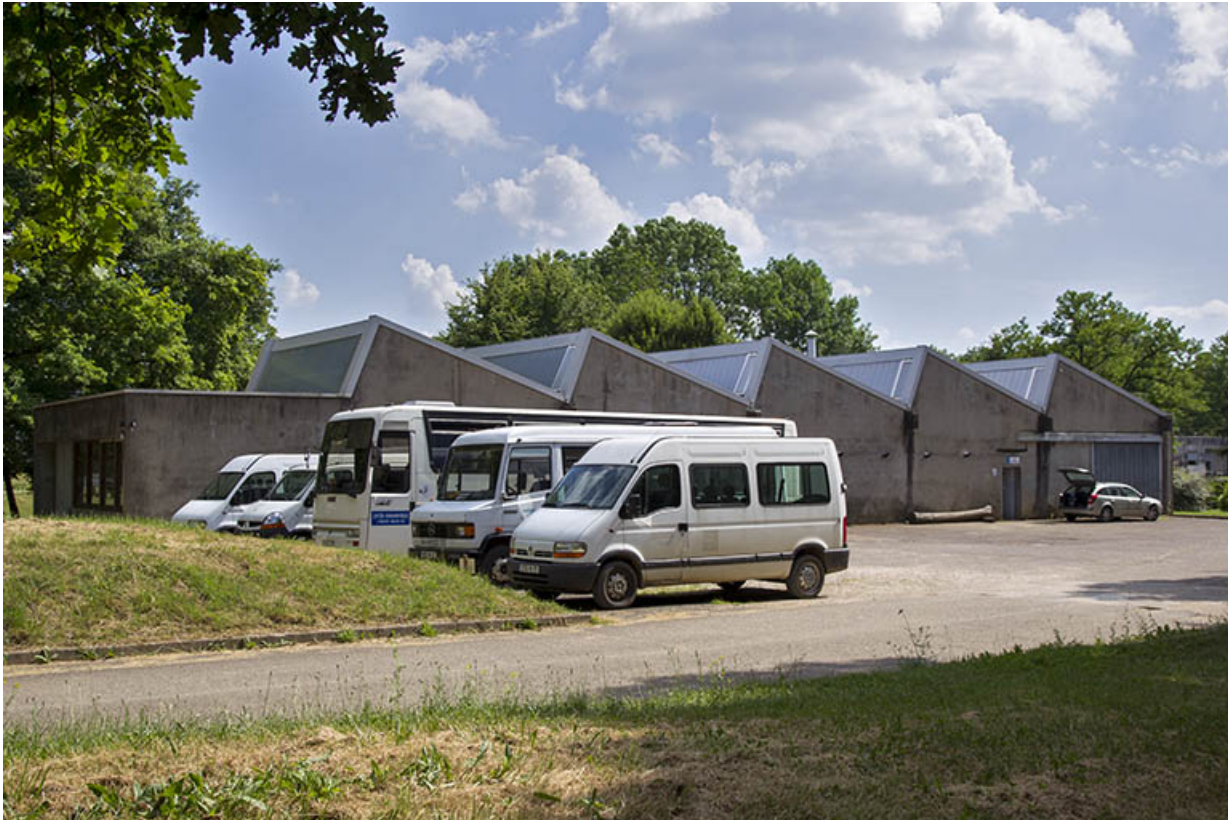
Façade antérieure - nord - de l'atelier.
