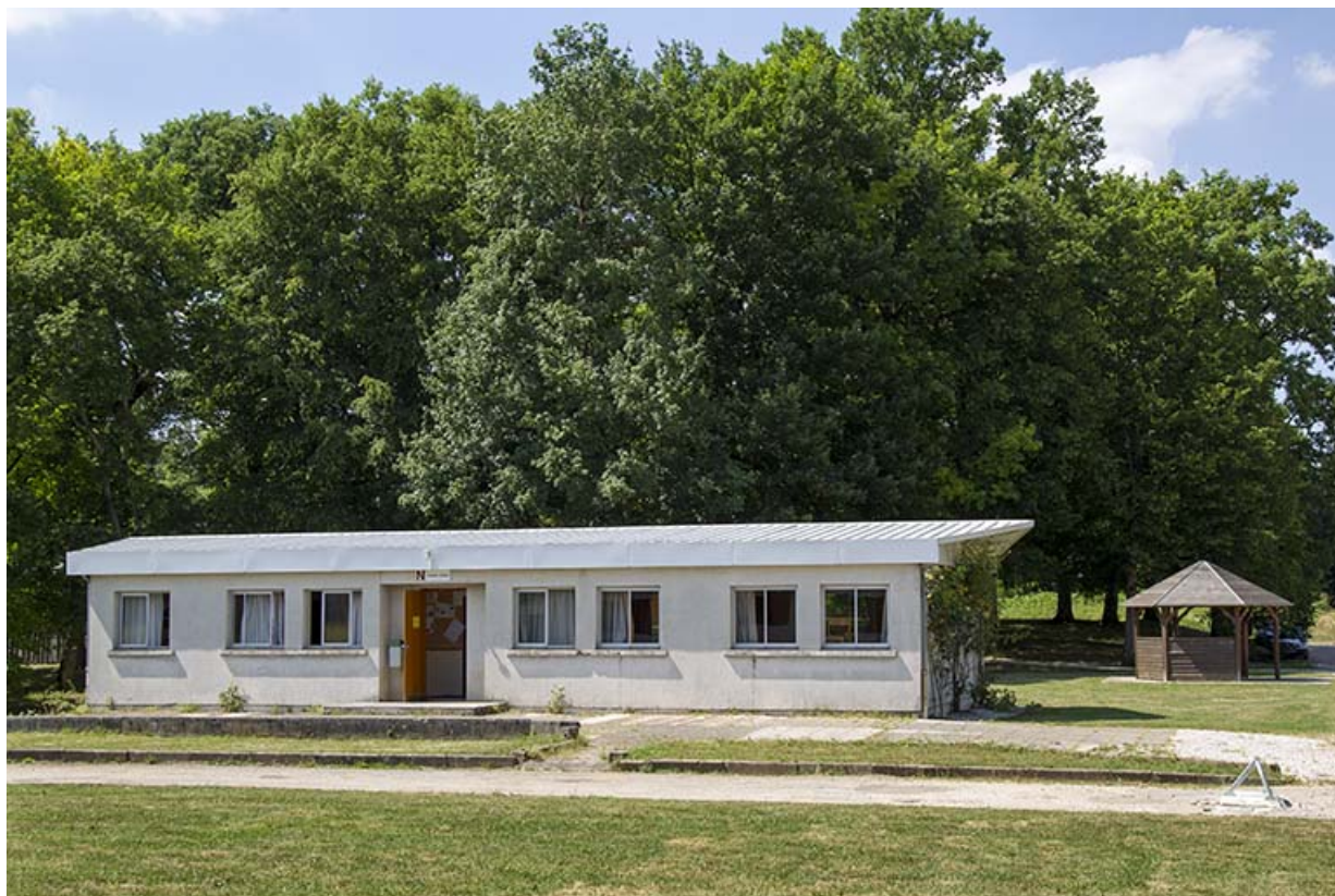
Façade sud des salles des classes préparatoires.
