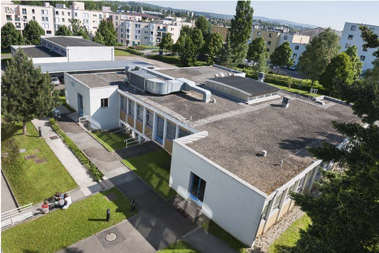
Angle sud-ouest du bâtiment de restauration.
