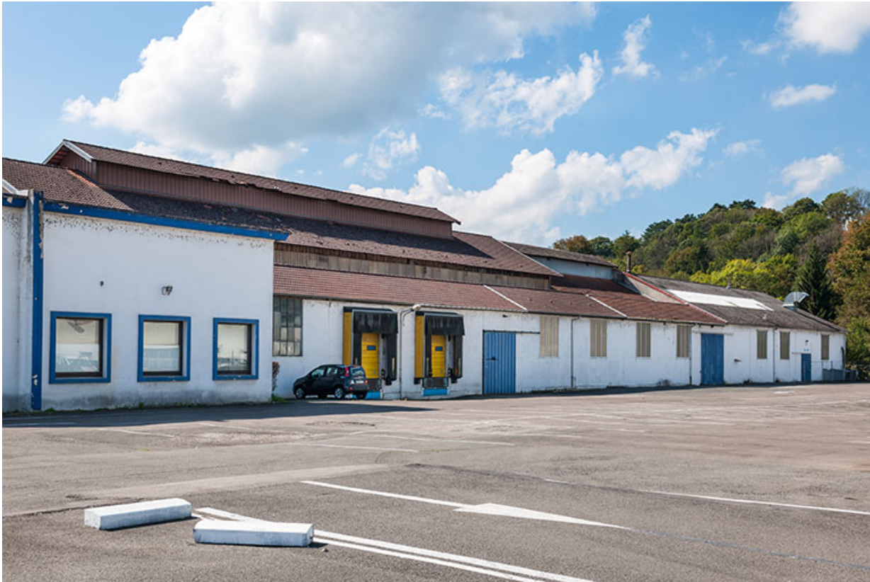
Façade nord vue de trois quarts.
