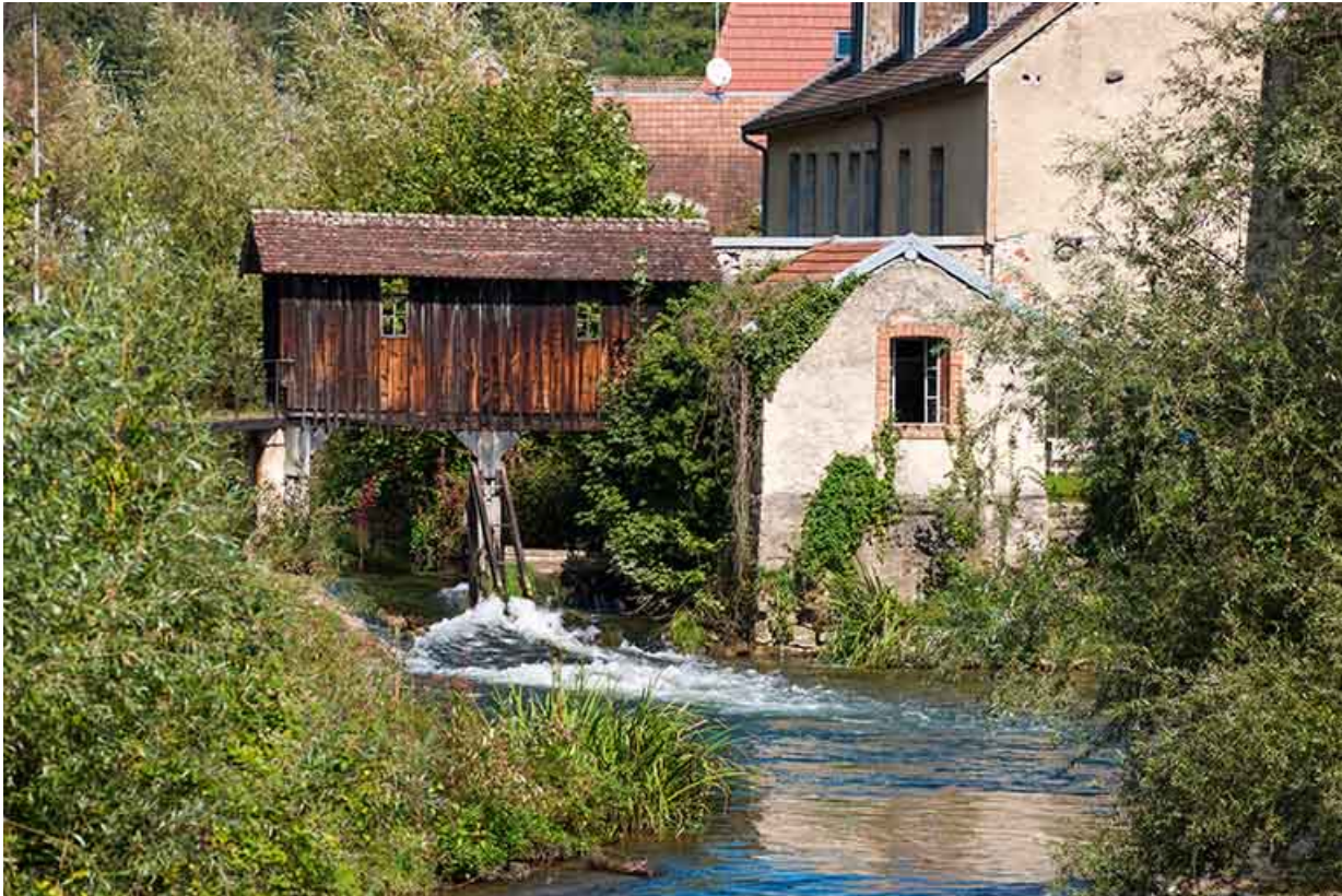
Vestiges du barrage depuis l'aval.
