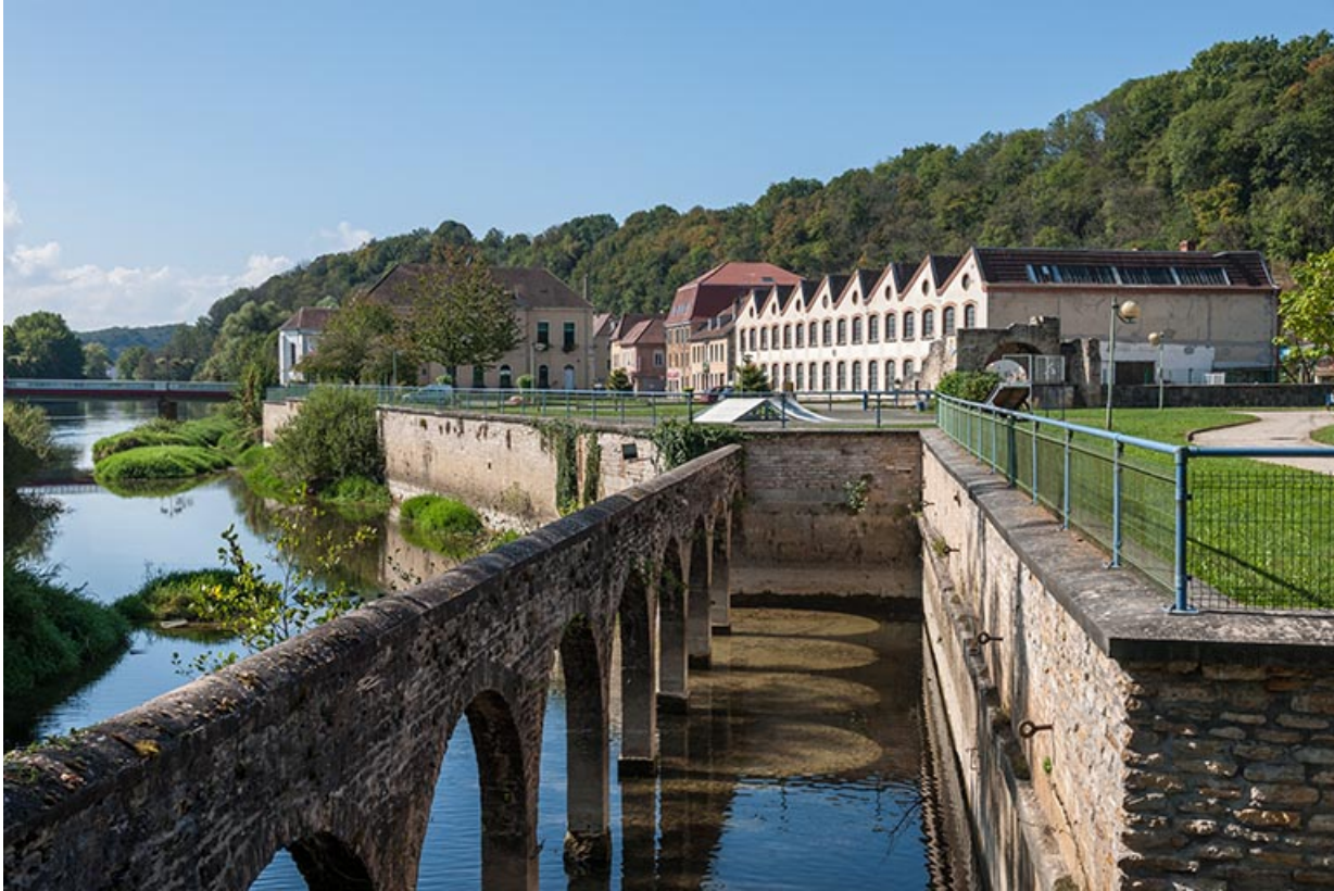
Vue d'ensemble depuis le nord du site.
