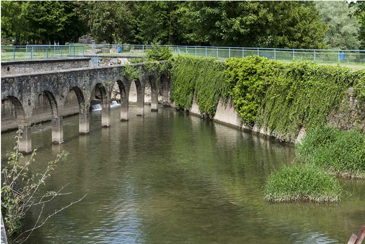
L'ancien canal de fuite.
