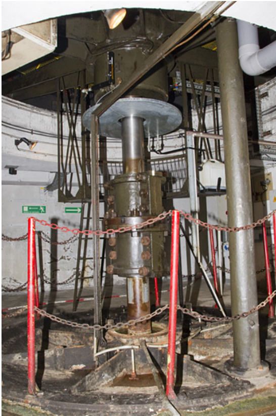
Détail de la transmission verticale d'une turbine.
