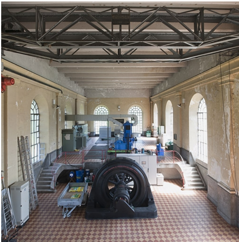
Vue intérieure, depuis le nord-ouest.
