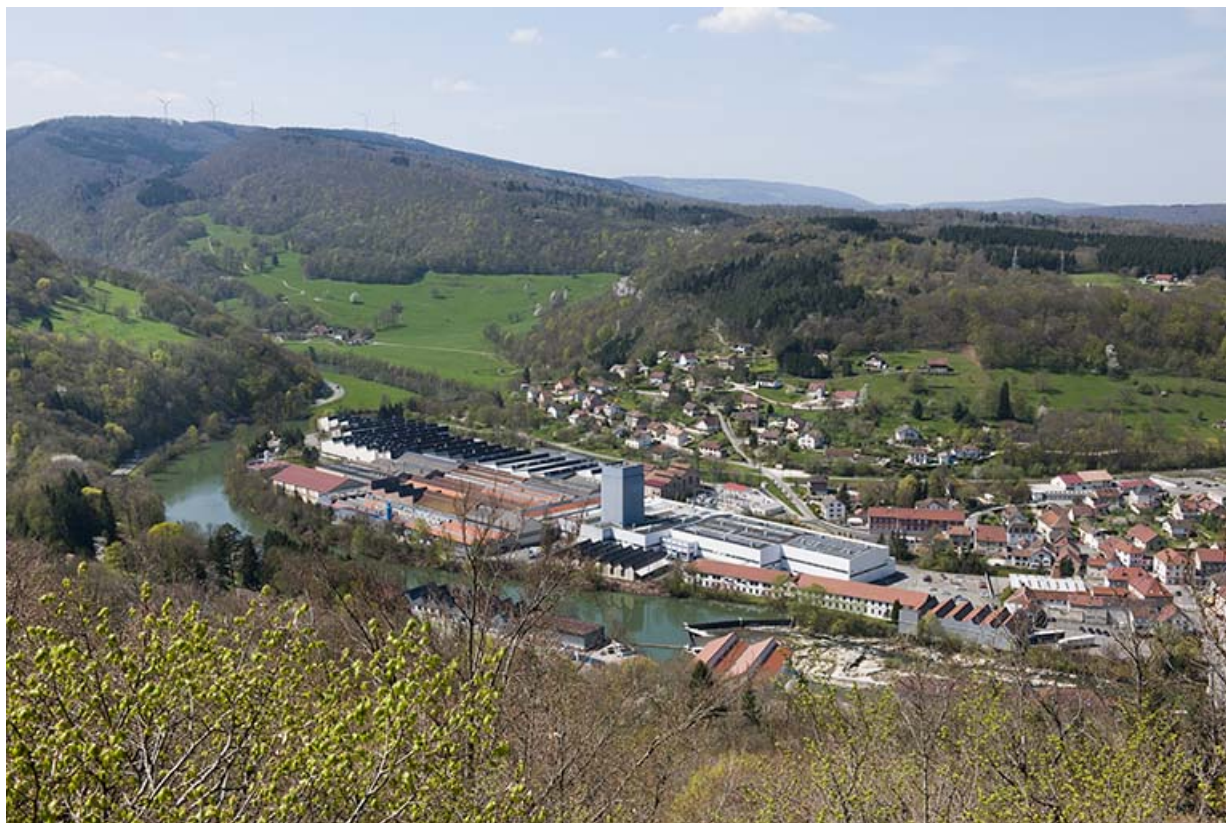
Vue plongeante depuis le nord-est.
