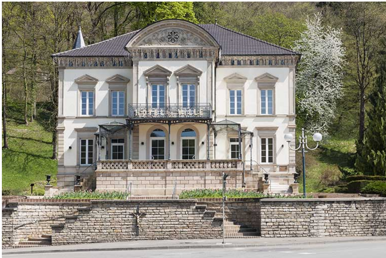
Façade antérieure vue de face.
