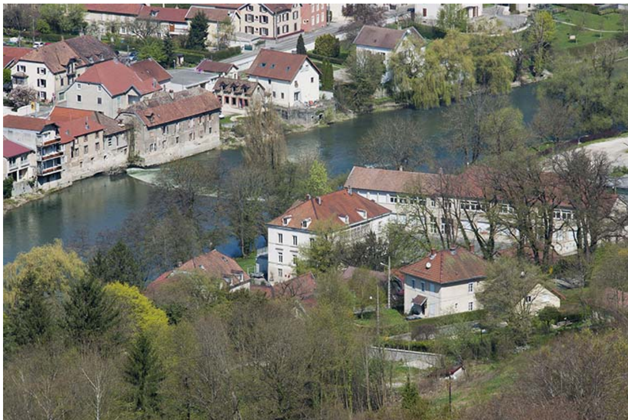
Vue d'ensemble plongeante depuis le sud-est.
