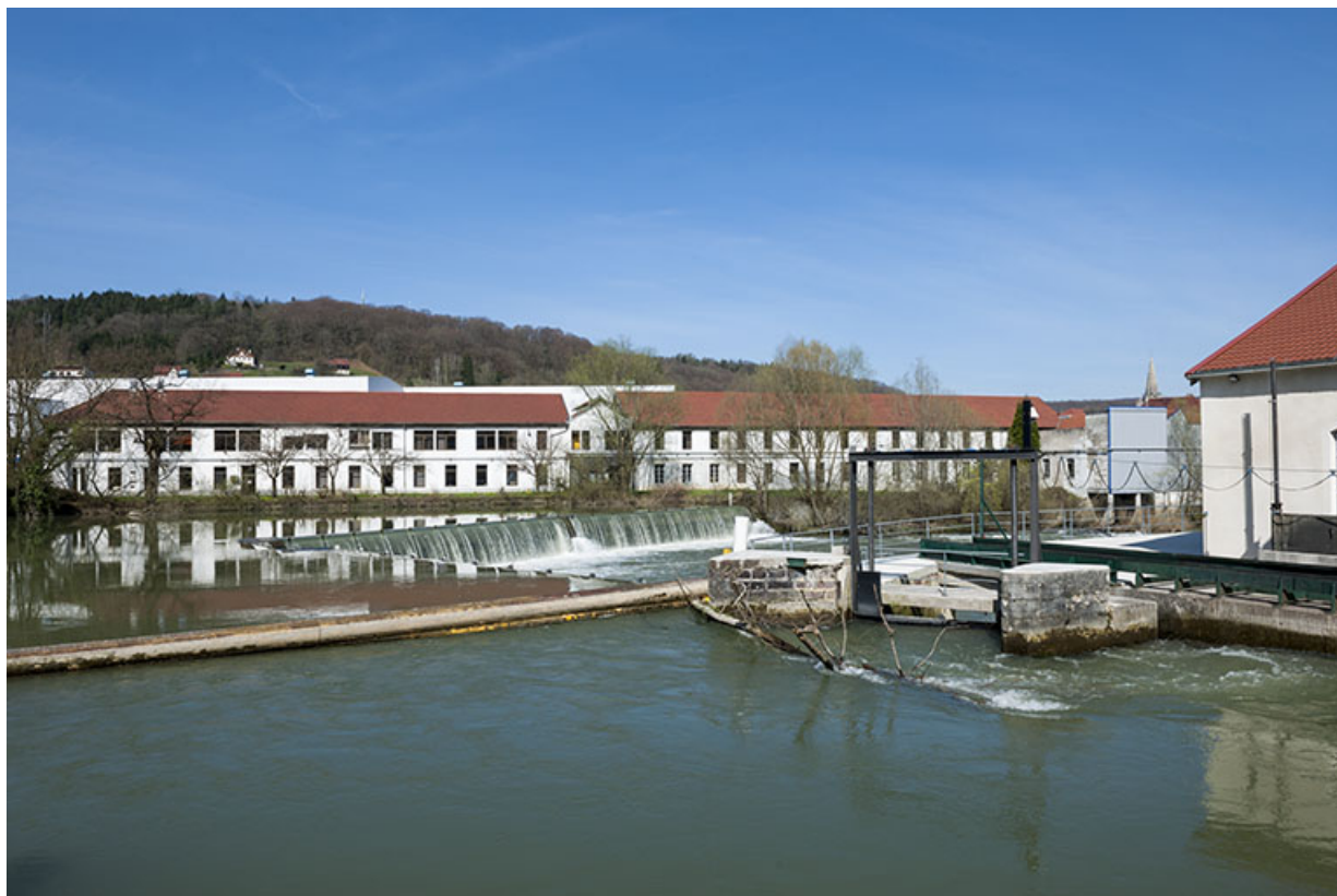
Usine (rive gauche) depuis l'est.
