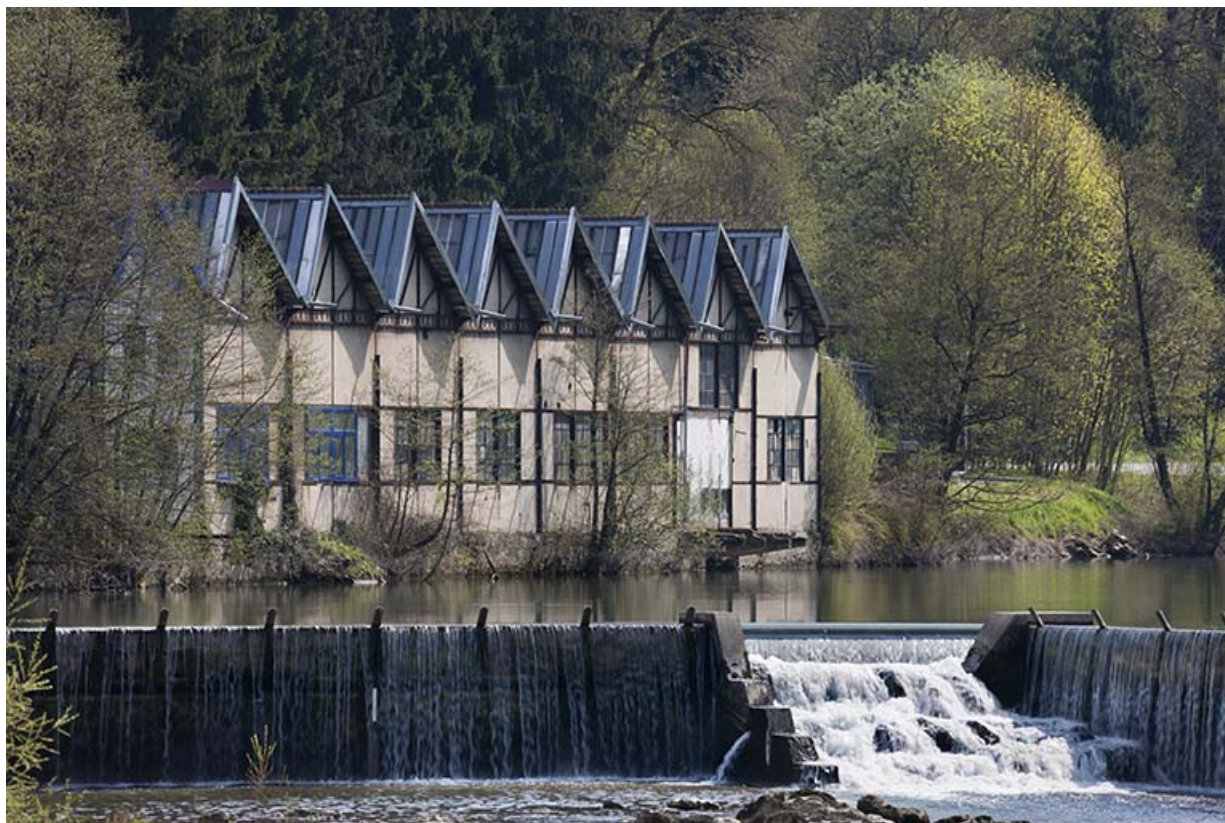
Ateliers sud de la rive droite.
