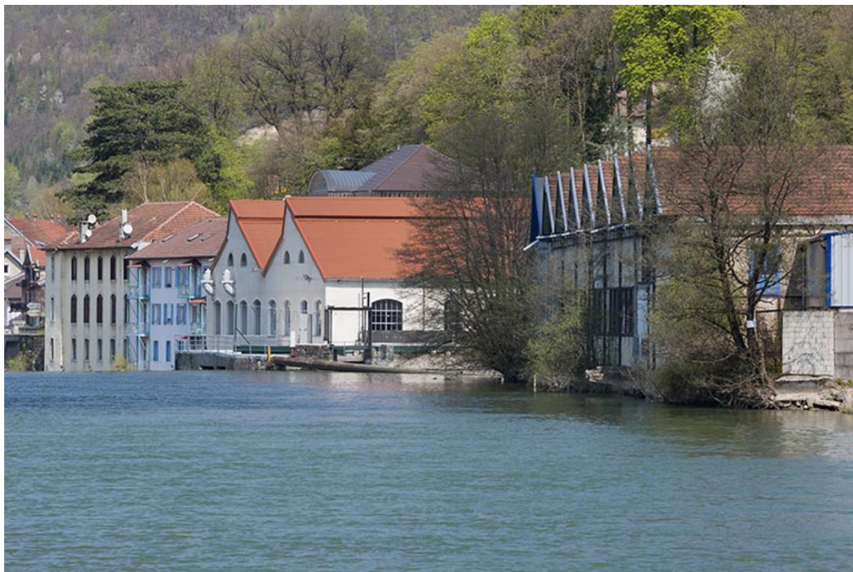
Vue de l'usine rive droite depuis l'amont.
