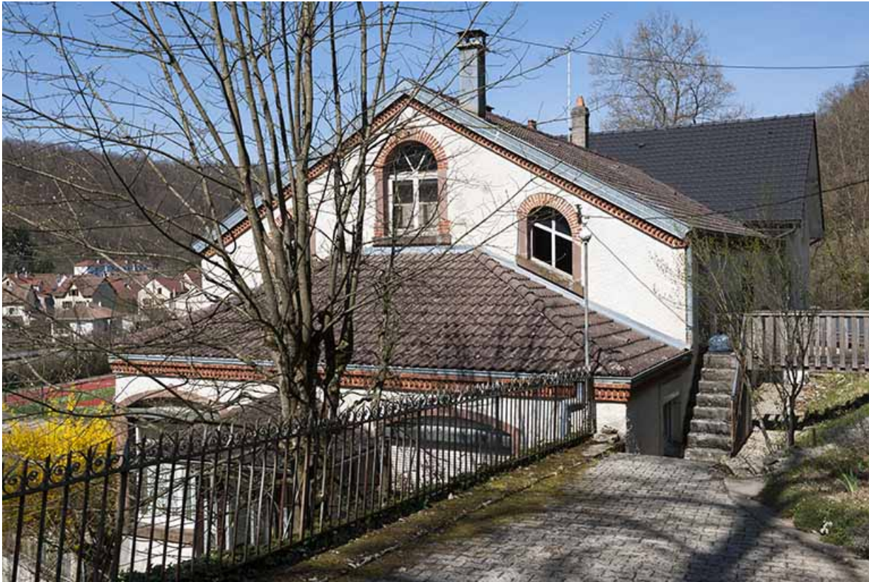
Pignon sud vu de trois quarts.
