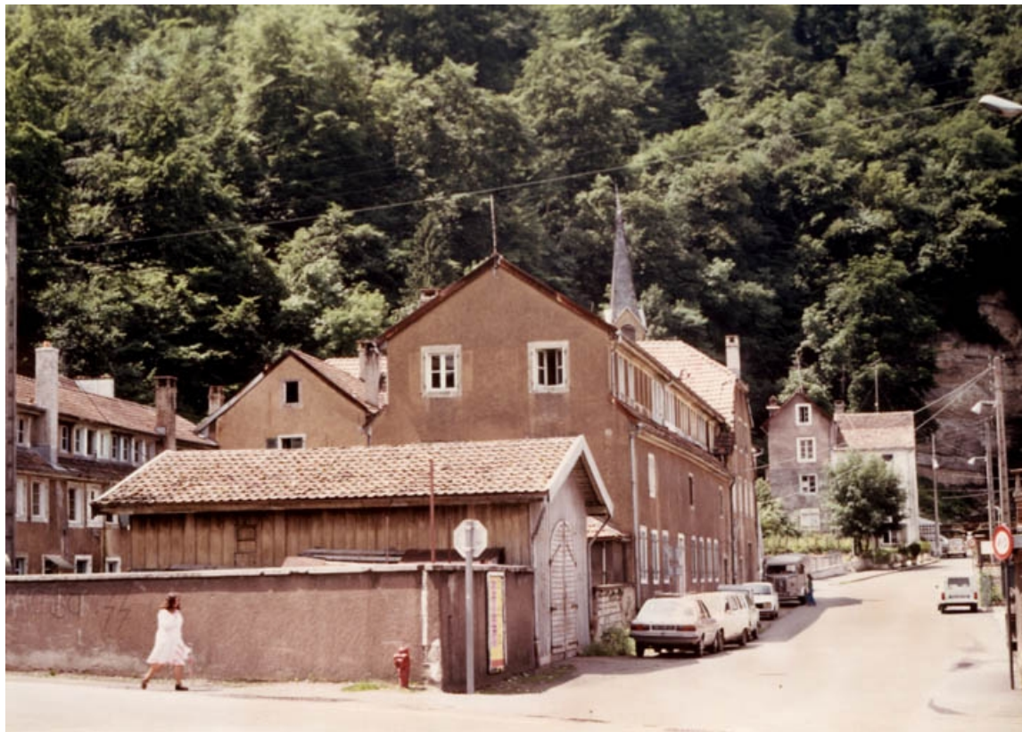
Vue d'ensemble des ateliers d'origine, depuis l'est.
