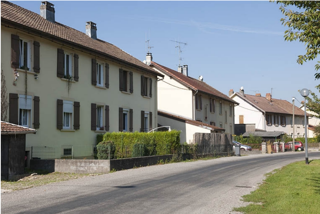
Vue d'ensemble depuis la rue du canal.
