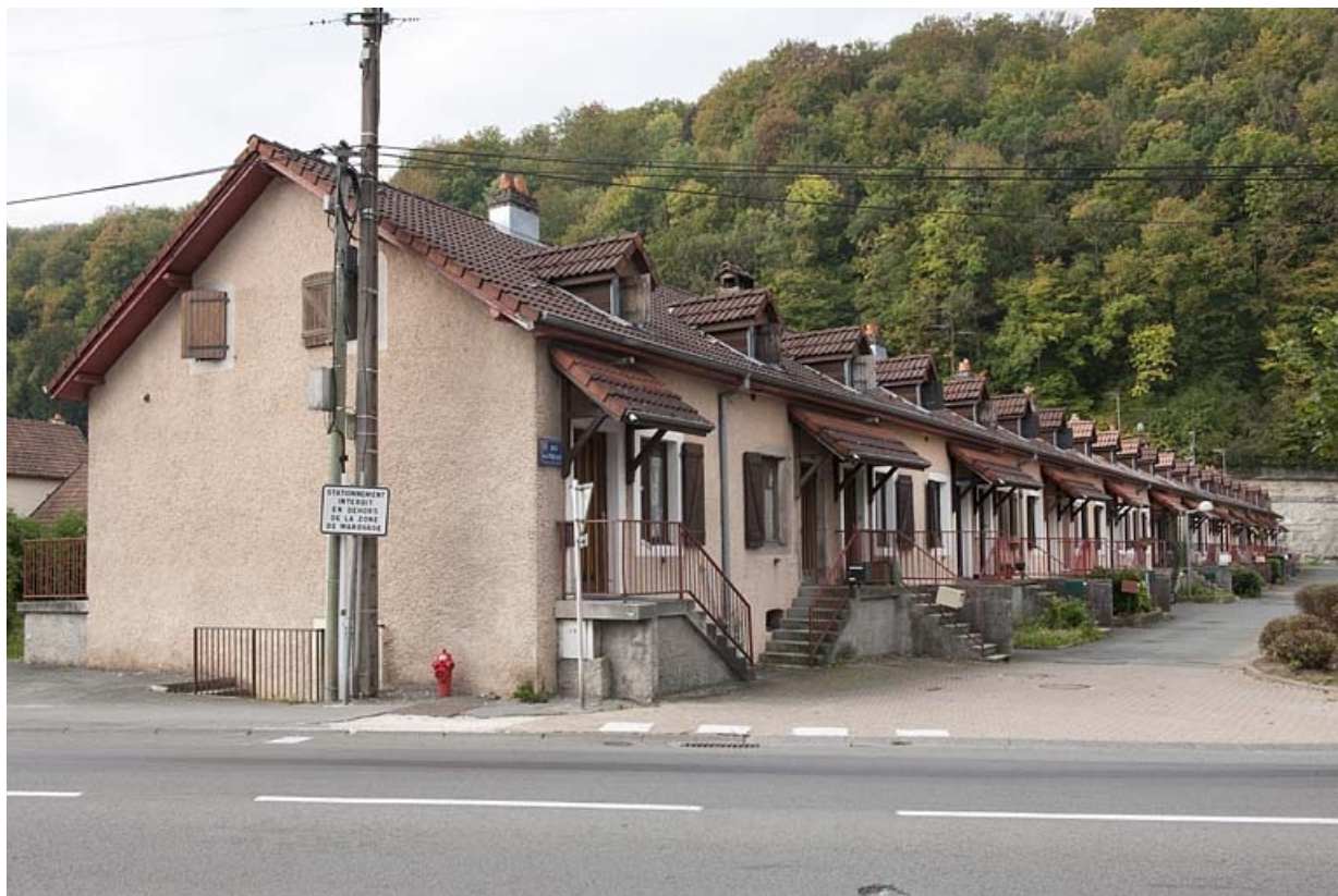
Caserne F. Vue depuis la route départementale.
