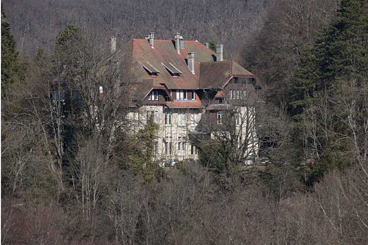
Vue éloignée depuis le sud-ouest.
