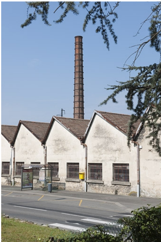
Vue rapprochée de l'atelier de laitonnerie.
