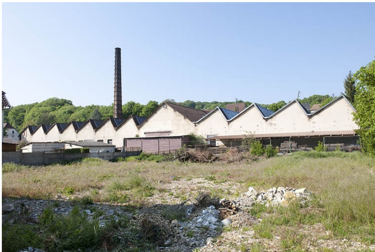
Atelier de laitonnerie. Façade ouest.
