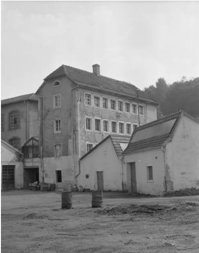
Elévation d'un ancien atelier en 1981.
