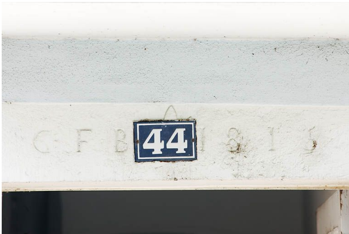
Détail du linteau de porte.
