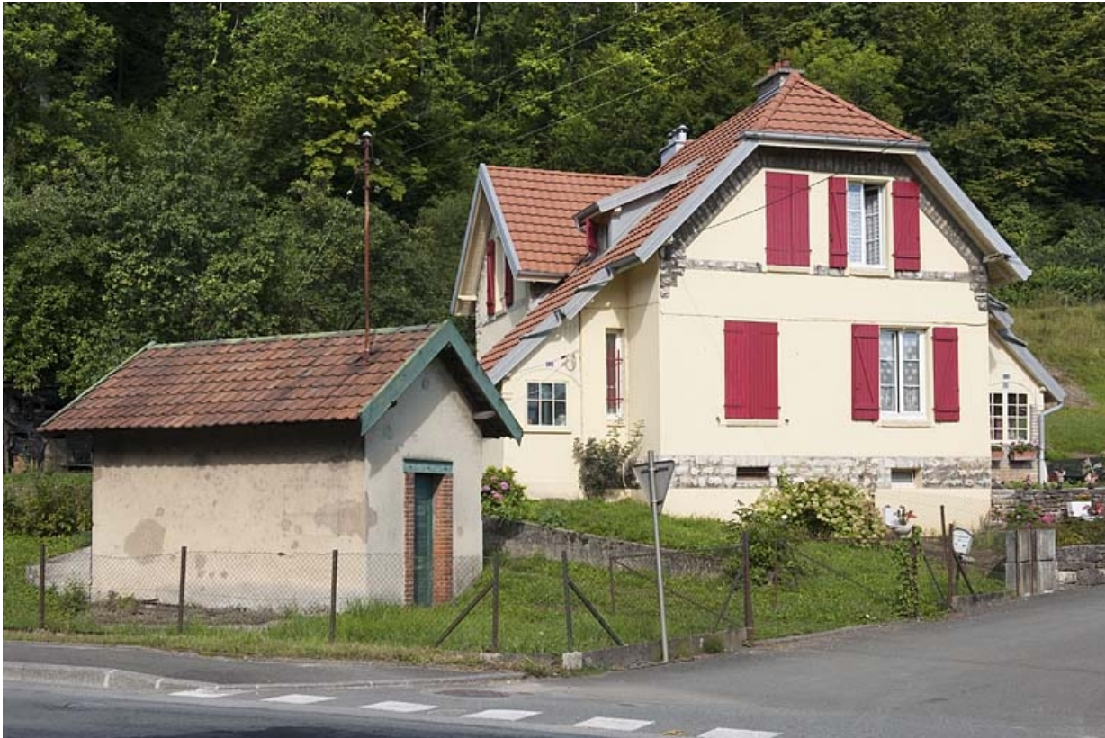
Maison jumelée. Façade antérieure.
