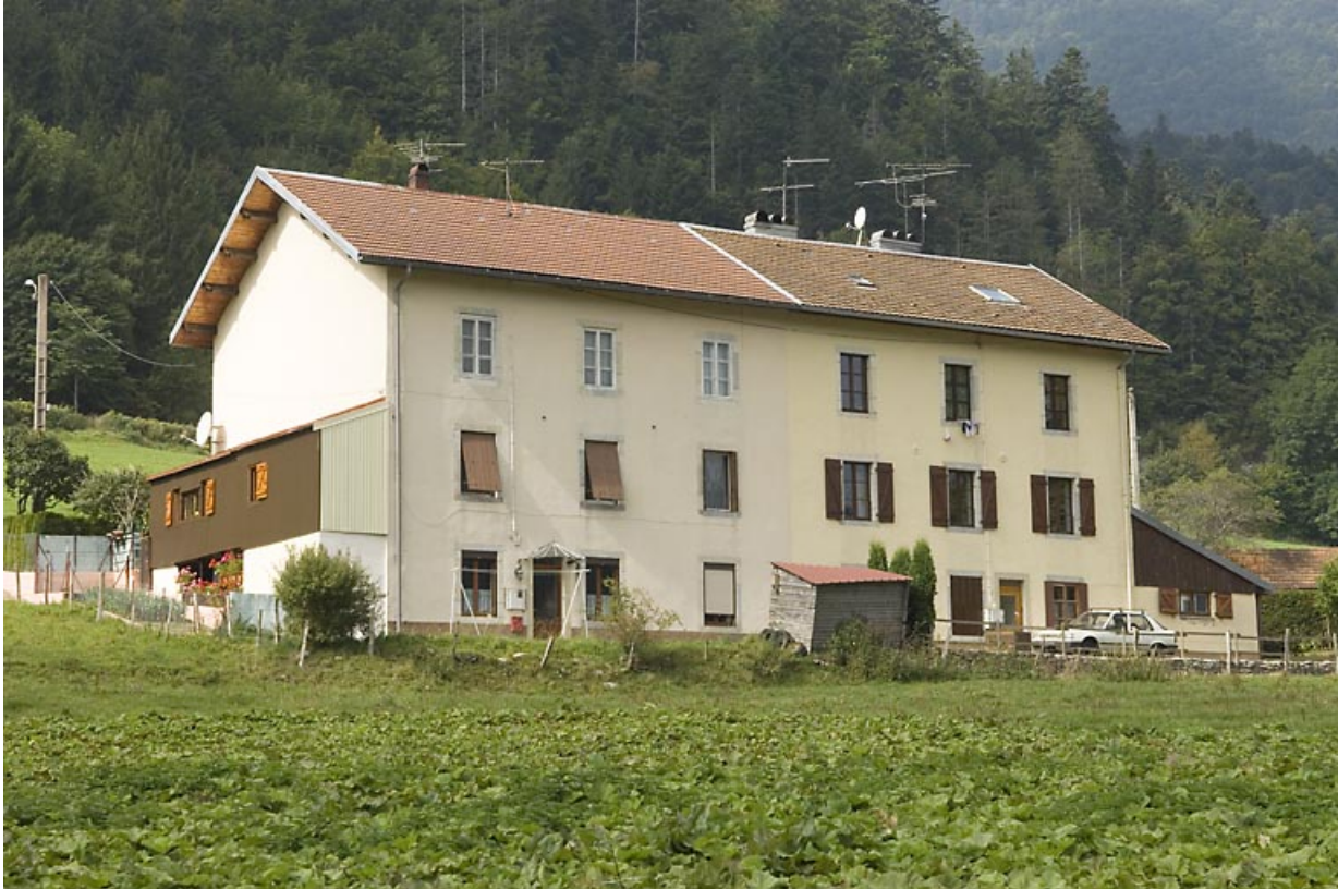
Immeuble à logements, façade postérieure.
