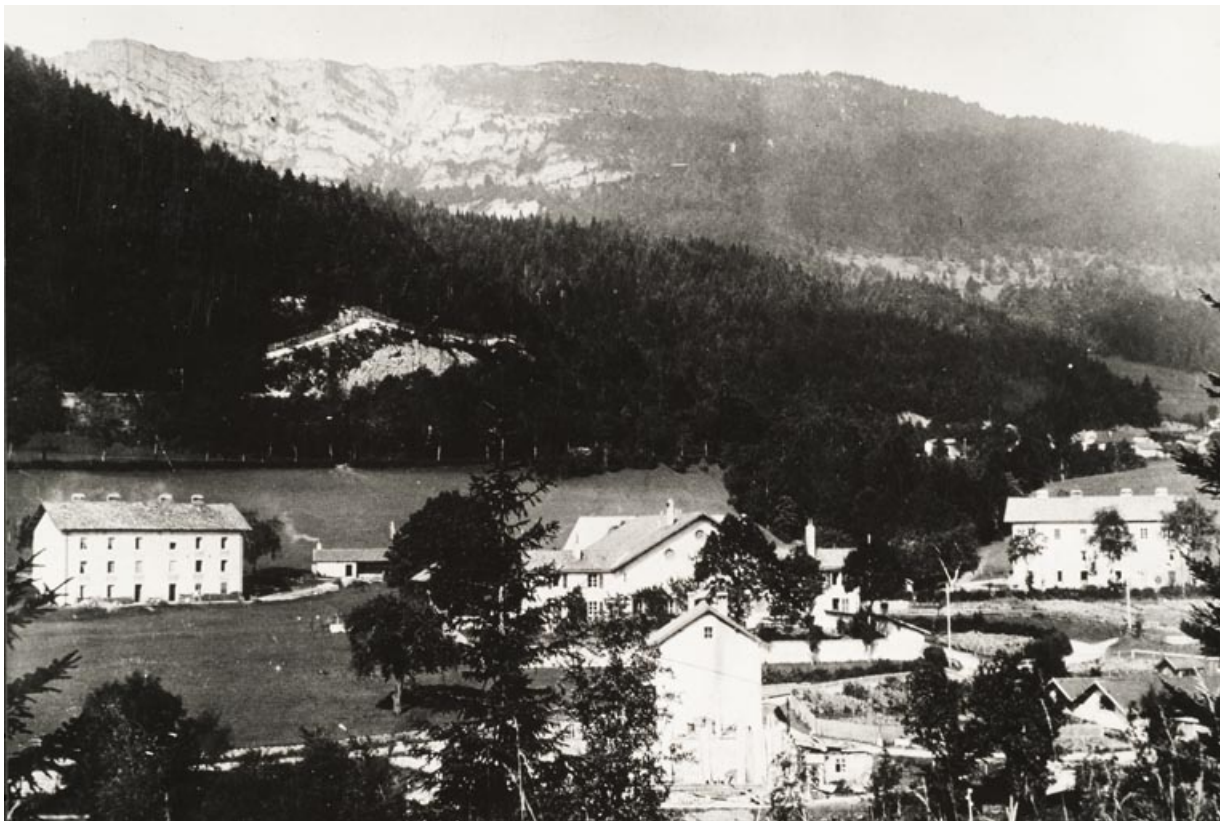
Vue générale après l'incendie de 1913
