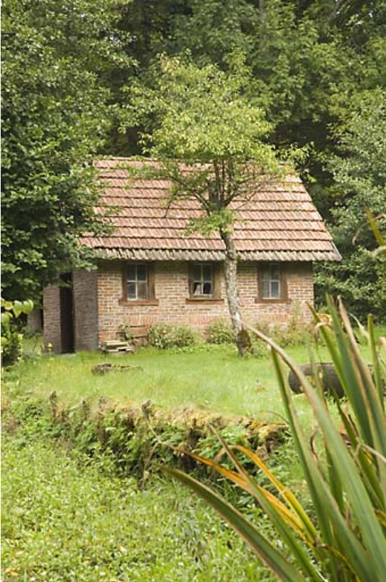
Remise : vue d'ensemble, depuis le sud.
