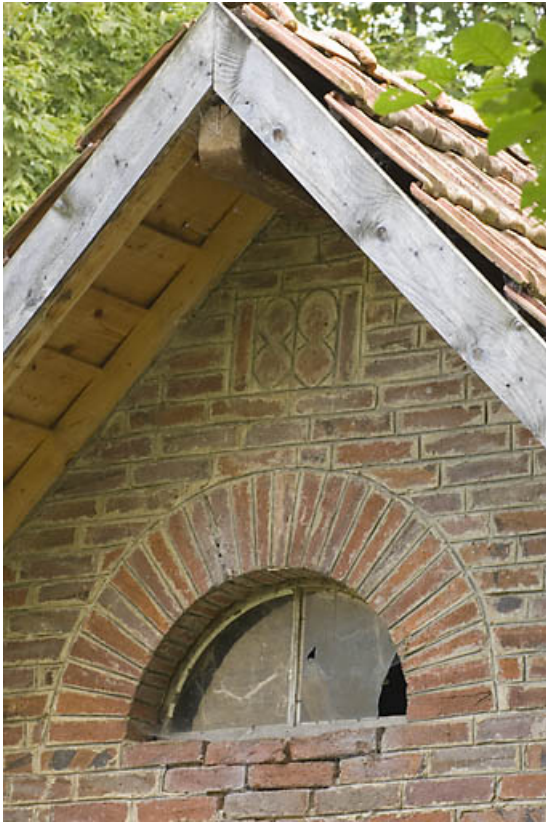
Remise : fenêtre et date.
