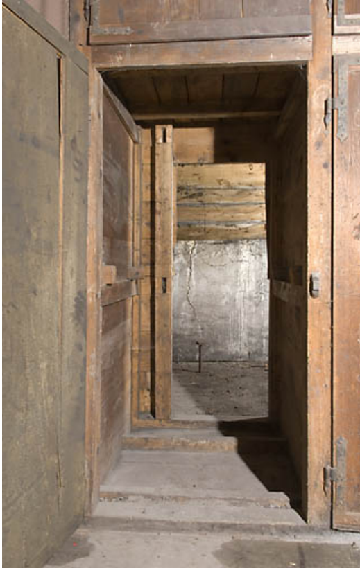
Usine, magasin industriel : placard ouvert.
