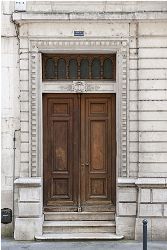
Façade antérieure : détail de la porte d'entrée.
