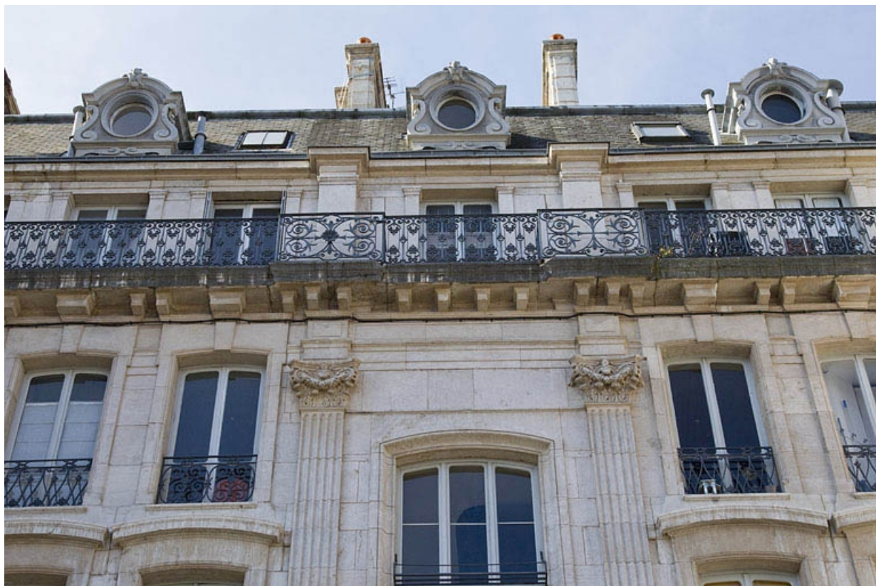
Façade antérieure : détail de la partie supérieure.
