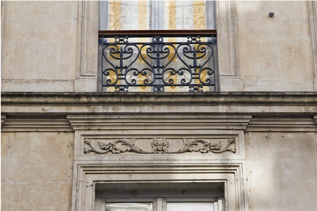
Façade antérieure : détail d'un garde-corps d'une fenêtre.
