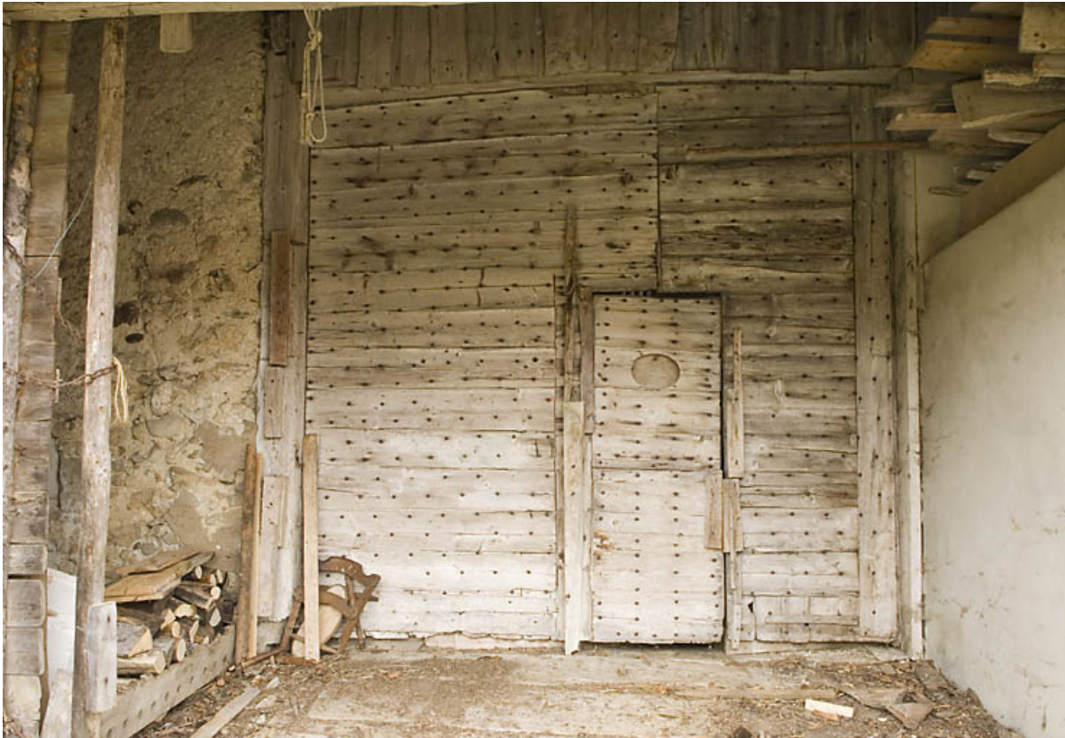
Façade postérieure : porte de la grange.
