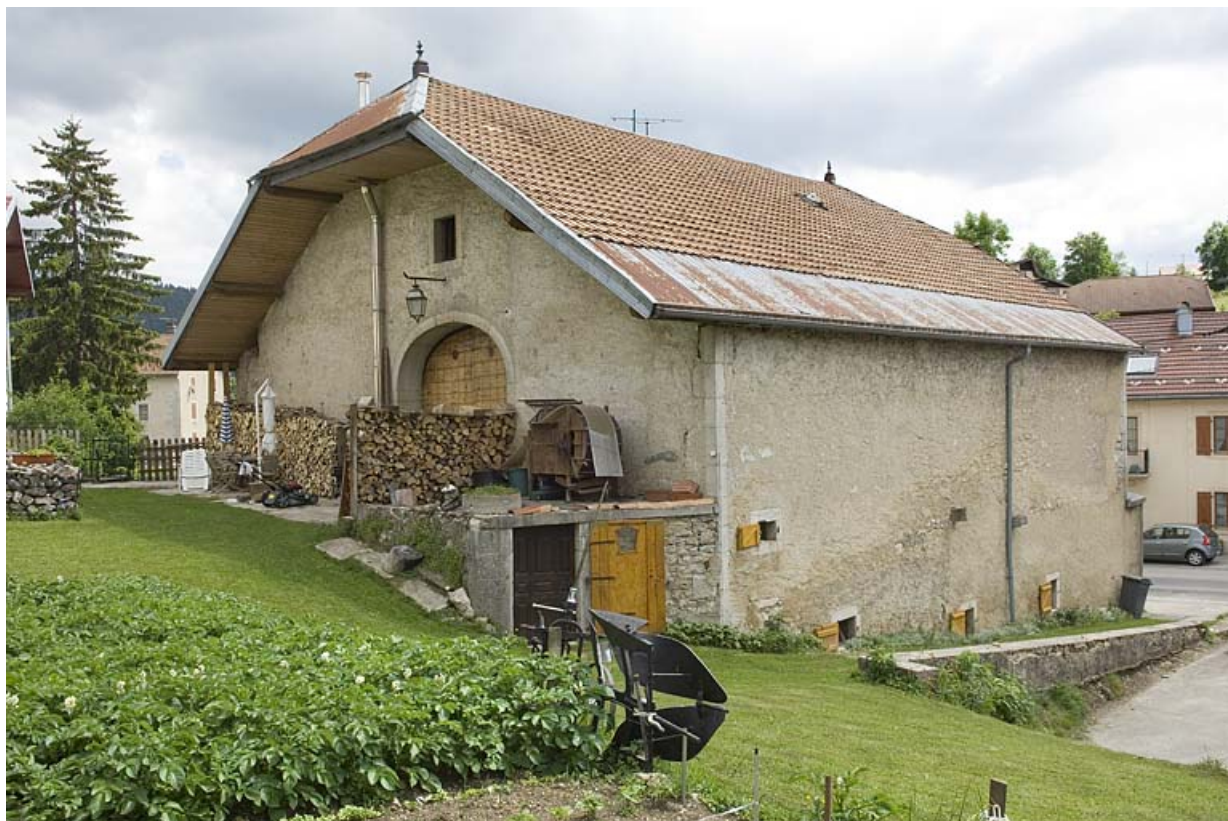
Façade postérieure et façade latérale gauche.
