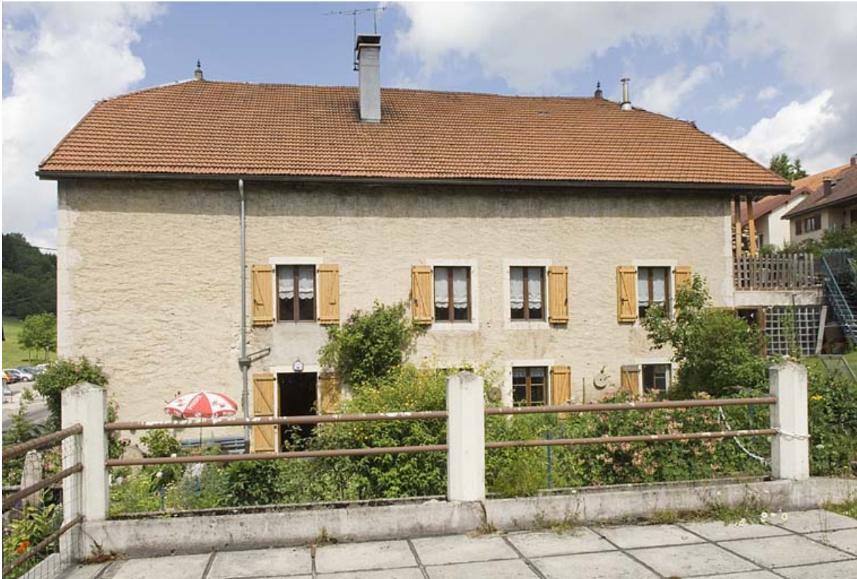
Façade latérale droite.
