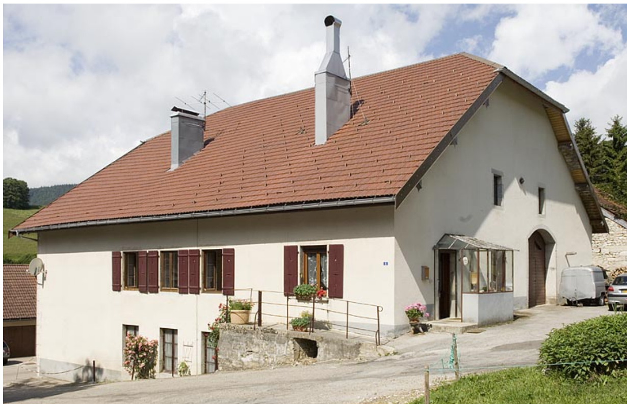
Façade postérieure et élévation latérale droite.
