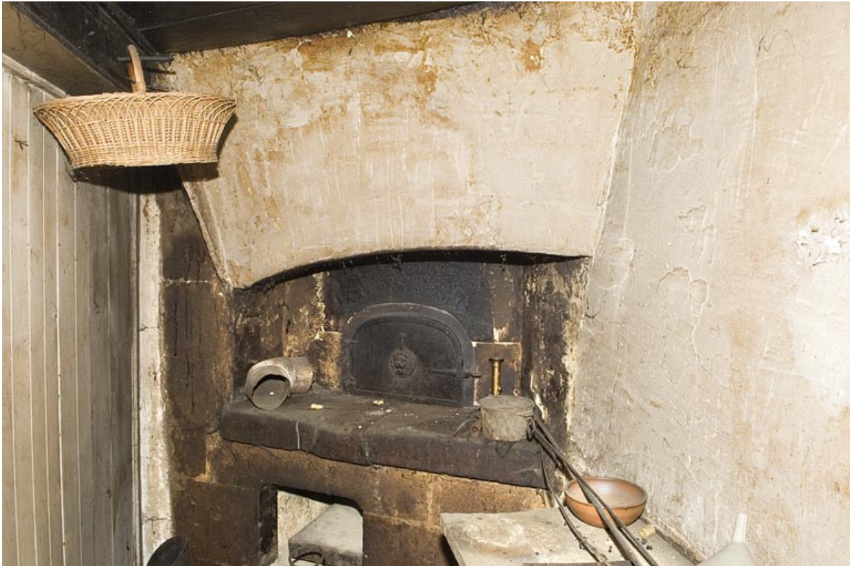
Cuisine au rez-de-chaussée : four à pain.
