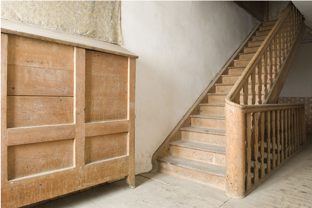
Escalier et coffre à grains.
